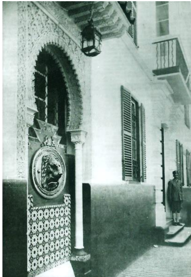
Fig. 186 Vista de la apertura realizada en la fachada del consulado español para instalar el buzón de cartas (Ramírez 2006)
