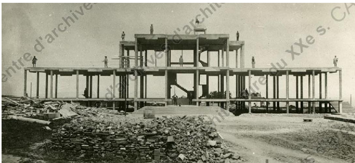
Fig. 205 La imagen muestra las obras de construcción del Institut Pasteur , se aprecia claramente la estructura de hormigón armado ( https://archiwebture.citedelarchitecture.fr/ )
