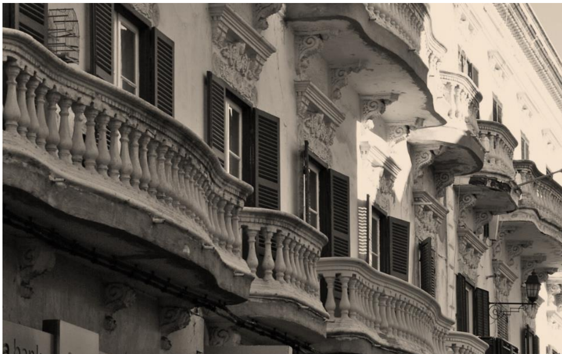
Fig. 178 Vista de una parte de la fachada del inmueble Braunschvig (Mas 2018)
