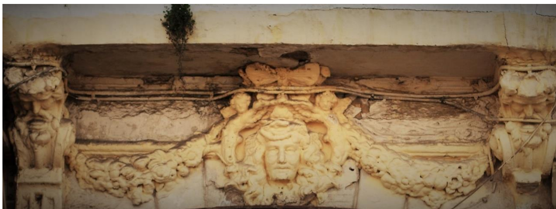
Fig. 196 Motivos decorativos situados en la fachada del edificio (Fot. Jordi Mas 2018)
