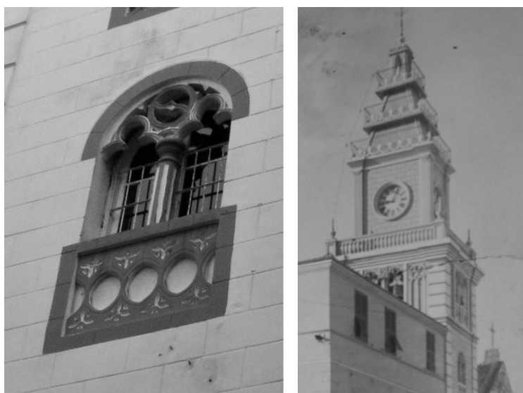
Fig. 197 A la izquierda una de las ventanas del campanario dividida por una columna que sustenta arcos trilobulados a la derecha vista general del campanario (Fot. Jordi Mas 2018; ADT, Albúm del Vicariato Apostólico de Marruecos)
