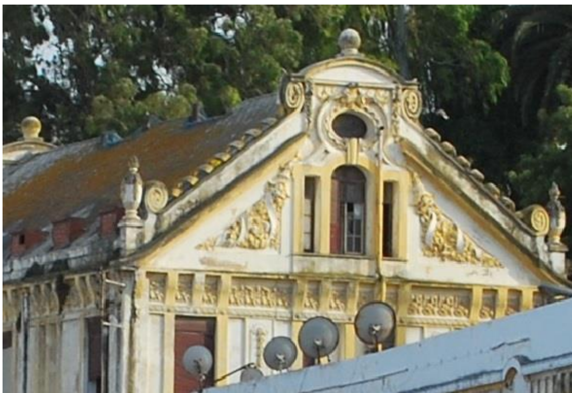
Fig. 195 Vista de uno de los inmuebles Renschhausen (Fot. Elisa Grilli 2013)
