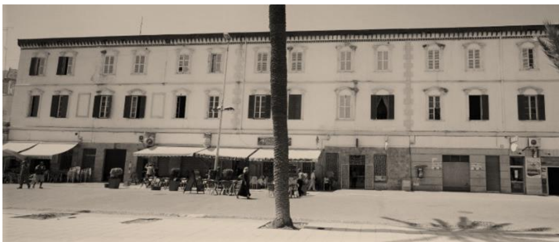
Fig. 208 Fachada del bloque de viviendas promovido por Aquiles Petri hacia finales del siglo XIX en la zona de la Playa (Fot. Jordi Mas 2018)
