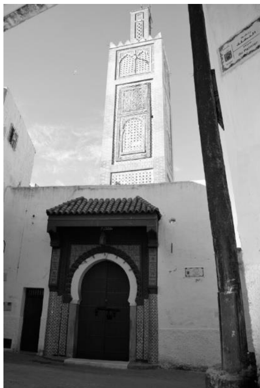
Fig. 151 Vista actual de la fachada de la mezquita Yedida y su minarete (Fot. Elisa Grilli 2015)
