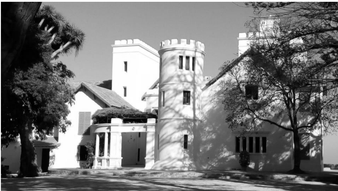
Fig. 206 Fachada principal de Villa Idonia, el edificio ha sido restaurado en 2017 (Fot. Jordi Mas 2018)
