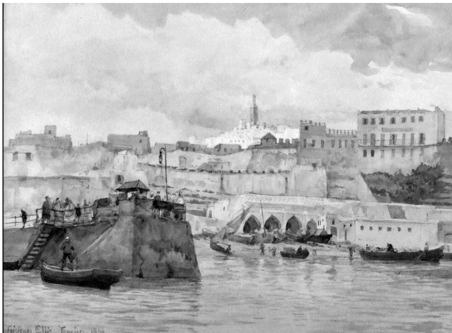
Fig. 200 Acuarela del pintor Tristram James Ellis (1844-1922), Tangiers (1894) en el que se representa, a la izquierda, el muelle de cemento de Meusburguer en el que se aprecian algunas grietas en la parte frontal ( http://19thcenturybritpaint.blogspot.com.es/2013/08/tristram-james-ellis.html )
