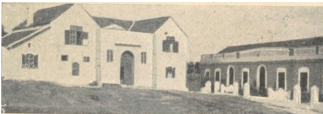
Fig. 223 Vista del edificio del hospital inglés (Cousin 1902)
