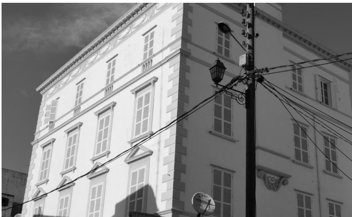
Fig. 174 Edificio de la Eastern Telegraph , situado en Rue Italie . En la fachada se aprecia un variado conjunto de elementos decorativos, frontones en las ventanas del primer piso, sillares de esquina resaltados y balaustradas en las ventanas del tercer piso. En la parte superior se disponen unos medallones unidos entre sí por festones o guirnaldas y el edificio se corona por una cornisa bajo la cual se encuentra una banda denticular. En el lateral se aprecian también unos motivos ornamentales formados por volutas (Fot. Elisa Grilli 2013)
