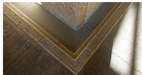
100 Vigas de hormigón y de acero; 101 Detalle de separación de pavimentos con muros (Fotos por el autor).
