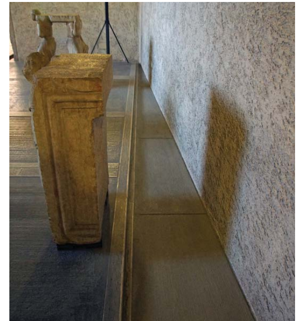
102 Plano de pavimento, distribución de piedra y cemento (a. C. Spa); 103 Detalle de separación de pavimento con muro (Foto por el autor).
