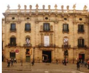
22 Palau de la Virreina-Centre de la Imatge
