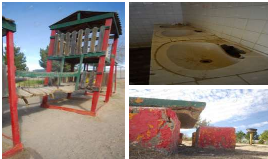
Fotografía 33. Instalaciones de El Chamizal
