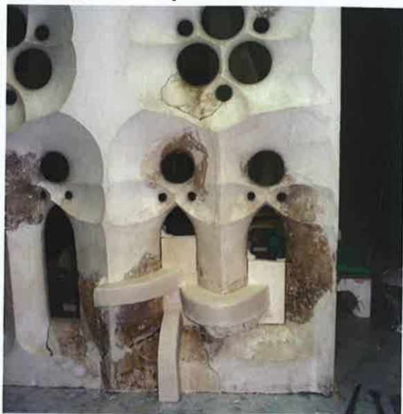
III.- Plantilles de brancals i ampit, en la zona original de la maqueta.
