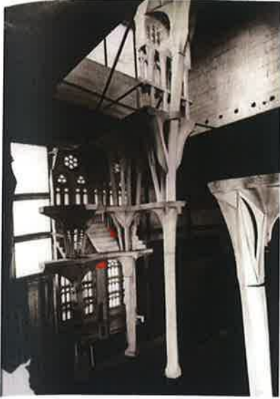
Imatge 7.99.- Situació del capitell del contrafort dins del conjunt.
