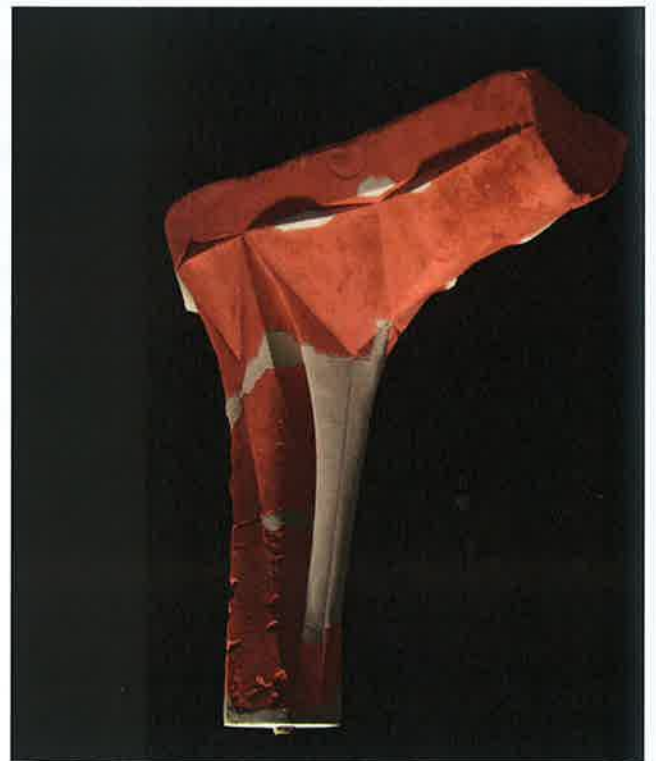
Imatge 6.2.- Exemple de model recuperat a partir de grans fragments. Capitell de la nau central a cota +20m. (R-016)
