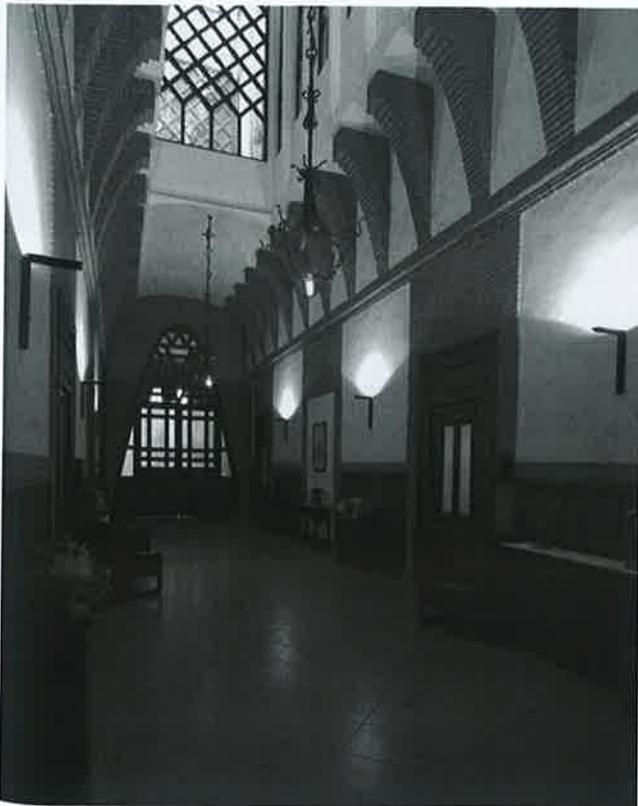
Imatge 9.20.- Paret de càrrega de planta de baixa amb les mènsules que suporten els arcs de la planta superior.
