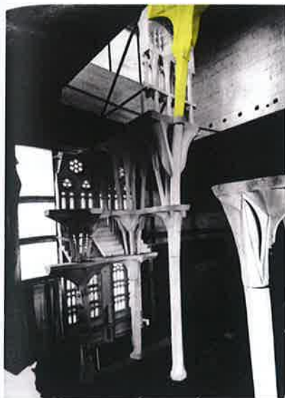
Imatge 7.83.- Situació de les voltes de la nau central dins del conjunt.
