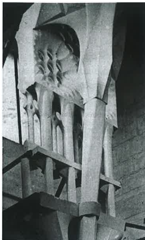
Imatge 7.84.- Detall del fust de les columnes i la zona de les voltes que es veu en la fotografia original FC-01.
