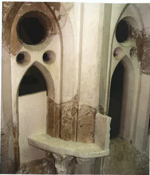
I.- Preparació de la base amb una placa de guix rejuntada, fixada amb plàstina.
