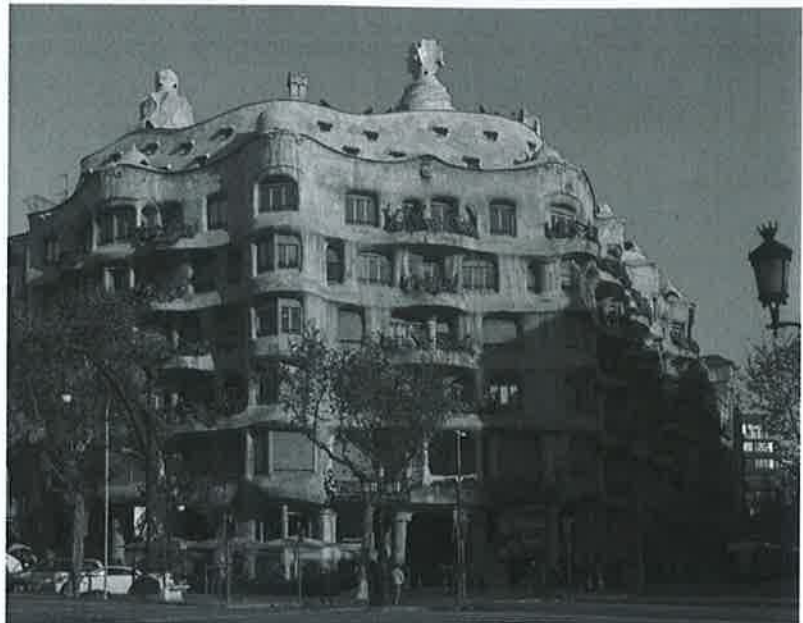
Imatge 5.30.- Casa Milà. Façana amb formes lliures.
