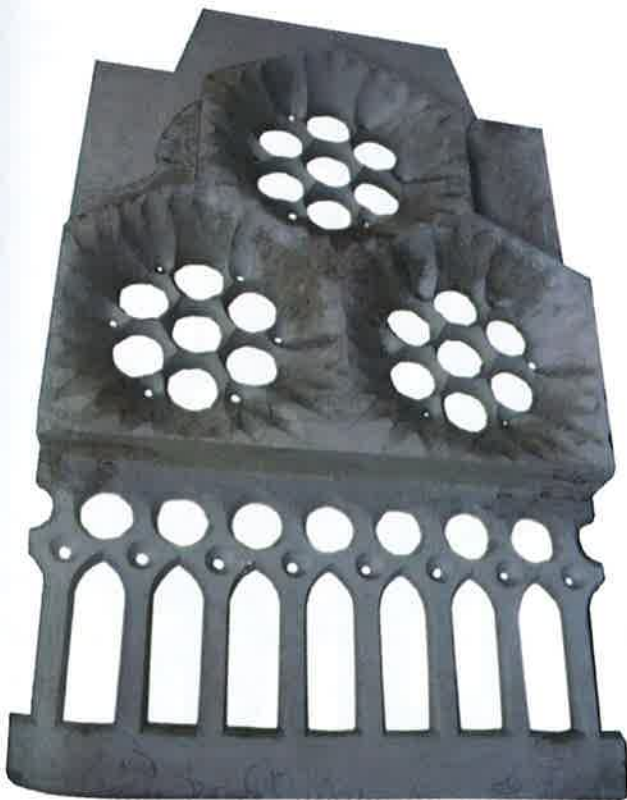
Imatge 7.148.- Finestral R-021. Cara interior. Peça original restaurada.
