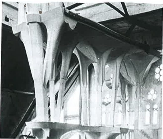
Imatge 7.74.- Detall de les voltes de 30m (R-081). Extret de la fotografia original FC-02.
