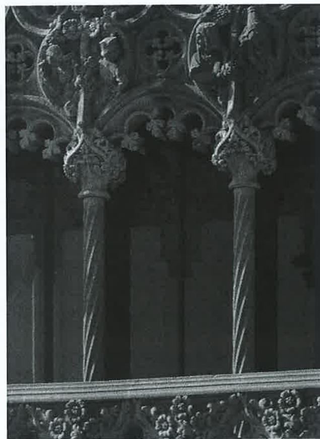
Imatge 5.14.- Tribuna amb columnes de gir helicoidal. Can Garí (1898-1900). Josep Puig i Cadafalch (arq.) Vegeu la similitud de les columnes i els capitells centrals amb els que projecta Gaudí pel claustre del Roser.
