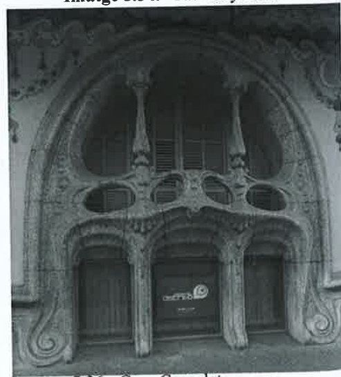
Imatge 5.36.- Casa Comalat. Mainells de la façana posterior.
