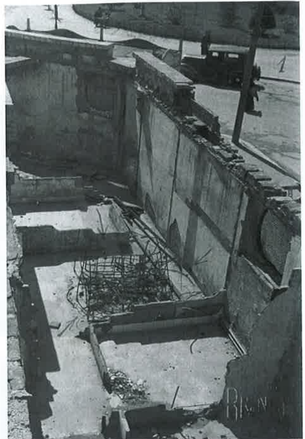
Imatge 4.16.- L'obrador destruït.
