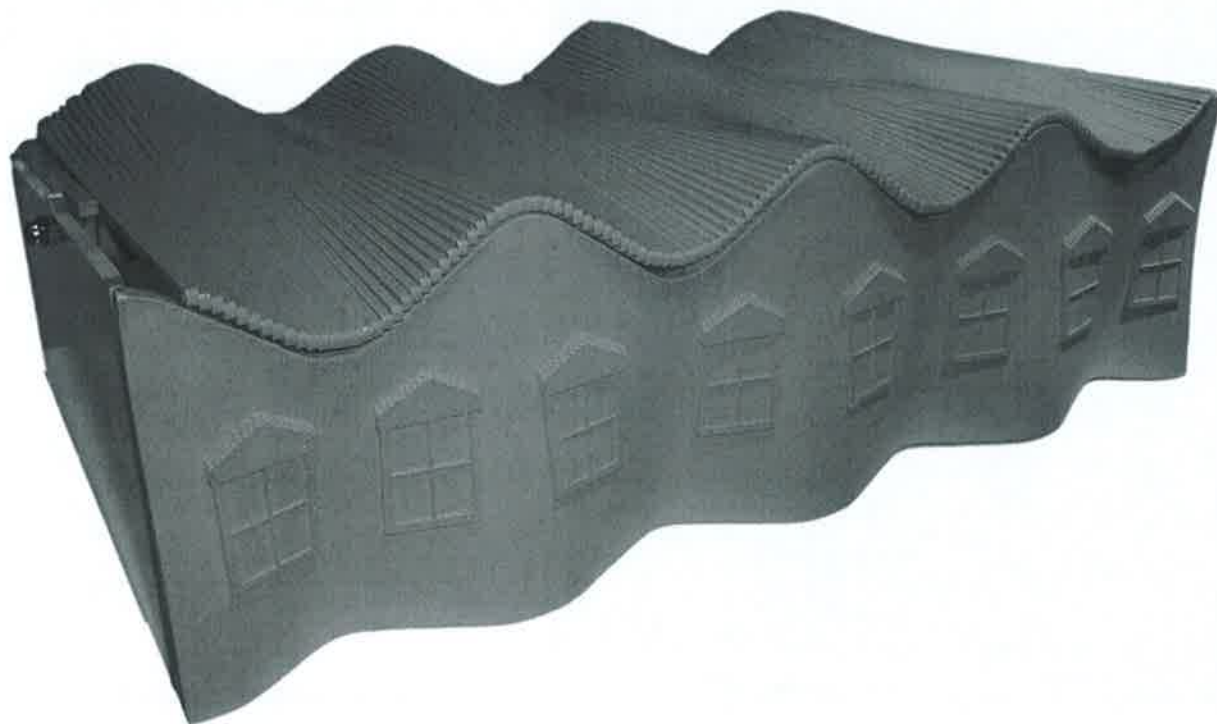
Imatge 5.39. - Maqueta de les escoles provisionals de la Sagrada Família, construïdes amb conoides. En la coberta s'indiquen les generatrius.
