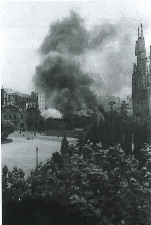
Imatge 4.15.- Destrucció de l'obrador. 19 de juliol de 1936.
