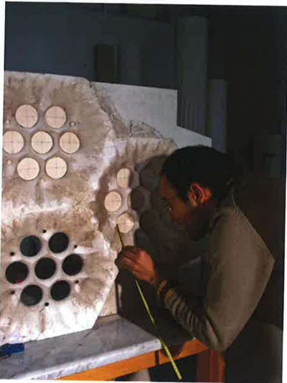
I + II.- Col·locació de cartolines dins dels òculs i anotació dels punts de pas de les generatrius dels hiperbolides que formen el dibuix estrellat.
