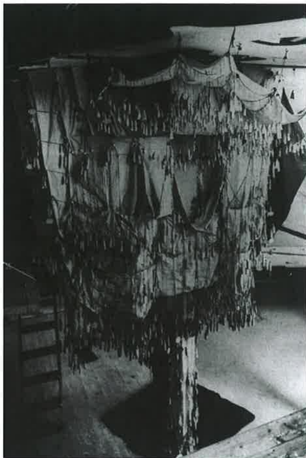
Imatge 9.27.- Maqueta funicular de l'església de la Colònia Güell.
