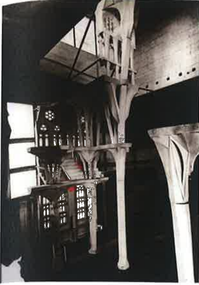
Imatge 7.111.- Situació del capitell del contrafort dins del conjunt.
