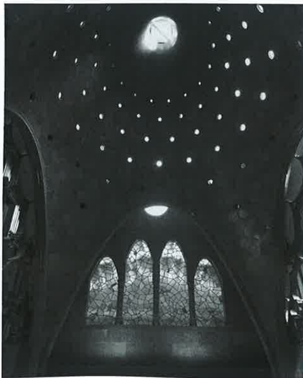
Imatge 5.2.- Cúpula del Palau Güell, similar a un paraboloides de revolució.
