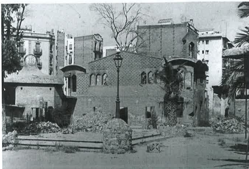
Imatge 4.17.- L'obrador destruït.
