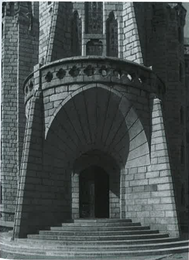
Imatge 5.22.- Palau episcopal d'Astorga. Arcs de l'accés modificats respecte el projecte original.
