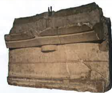
Imatge 7.159.- Fragments originals del finestral: zona dels òculs en mal estat (dalt) i base quasi intacta (a baix).
