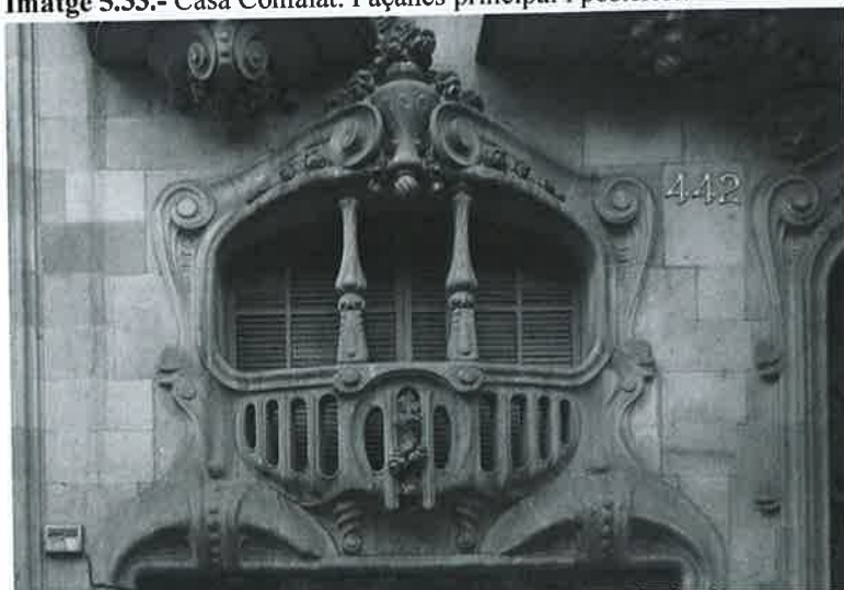
Imatge 5.35.- Casa Comalat. Mainells de la façana principal.
