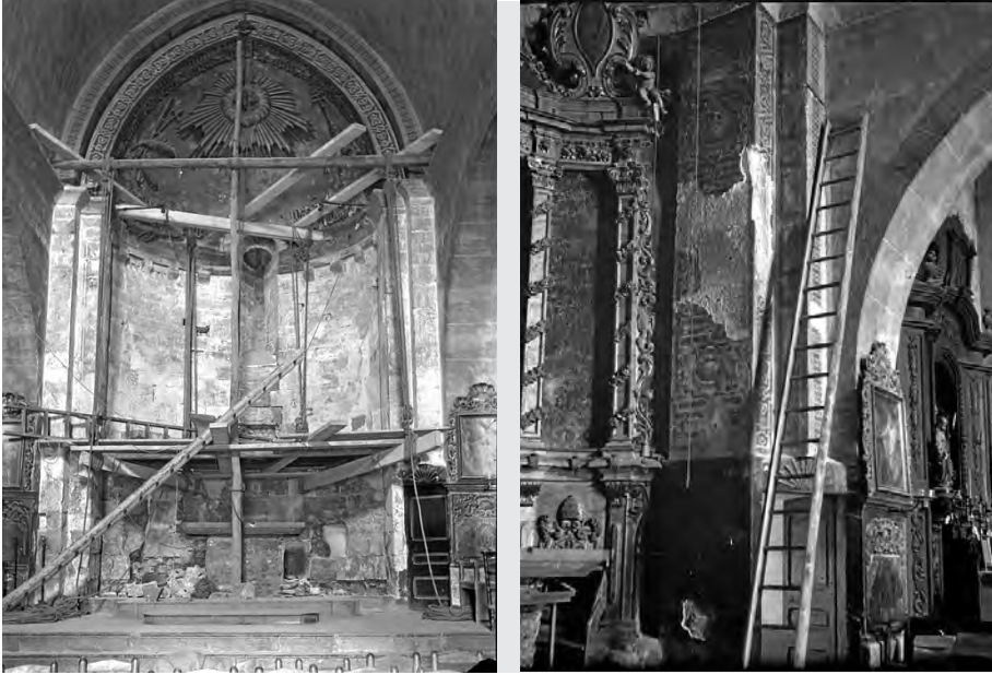
126 i 127. Imatge de les obres del presbiteri (Arxiu Joan Sutrà. Fotografia AS_mn0226) i de la retirada de la capa de guix que cobria la pedra original (Arxiu Joan Sutrà. Fotografia AS_mn0225).
