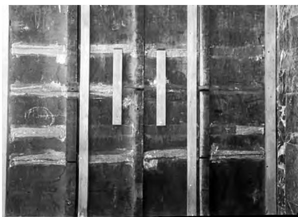
219. . Imatge del revers d'una taula, probablement la central, on s'aprecien els nous travessers de fusta (Arxiu Joan Sutrà. Fotografia AS_mn1186).
