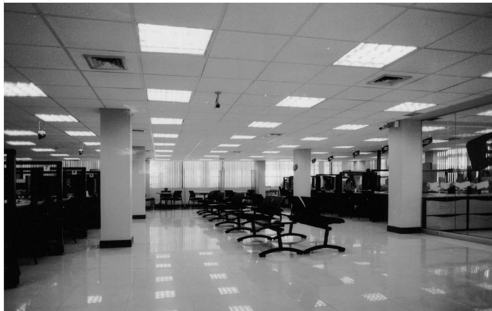
368 La planta perfectamente cuadrada del BIC se soporta en 16 columnas, cuatro de las cuales se ubican al interior y no anexas a la fachada, en el perímetro. En algunos pisos se usa la distribución abierta de oficinas, pero en otros se lleva a cabo una subdivisión un poco forzada, resuelta con un corredor longitudinal y crujías a ambos lados, similar al sistema usado en las torres de planta rectangular.
