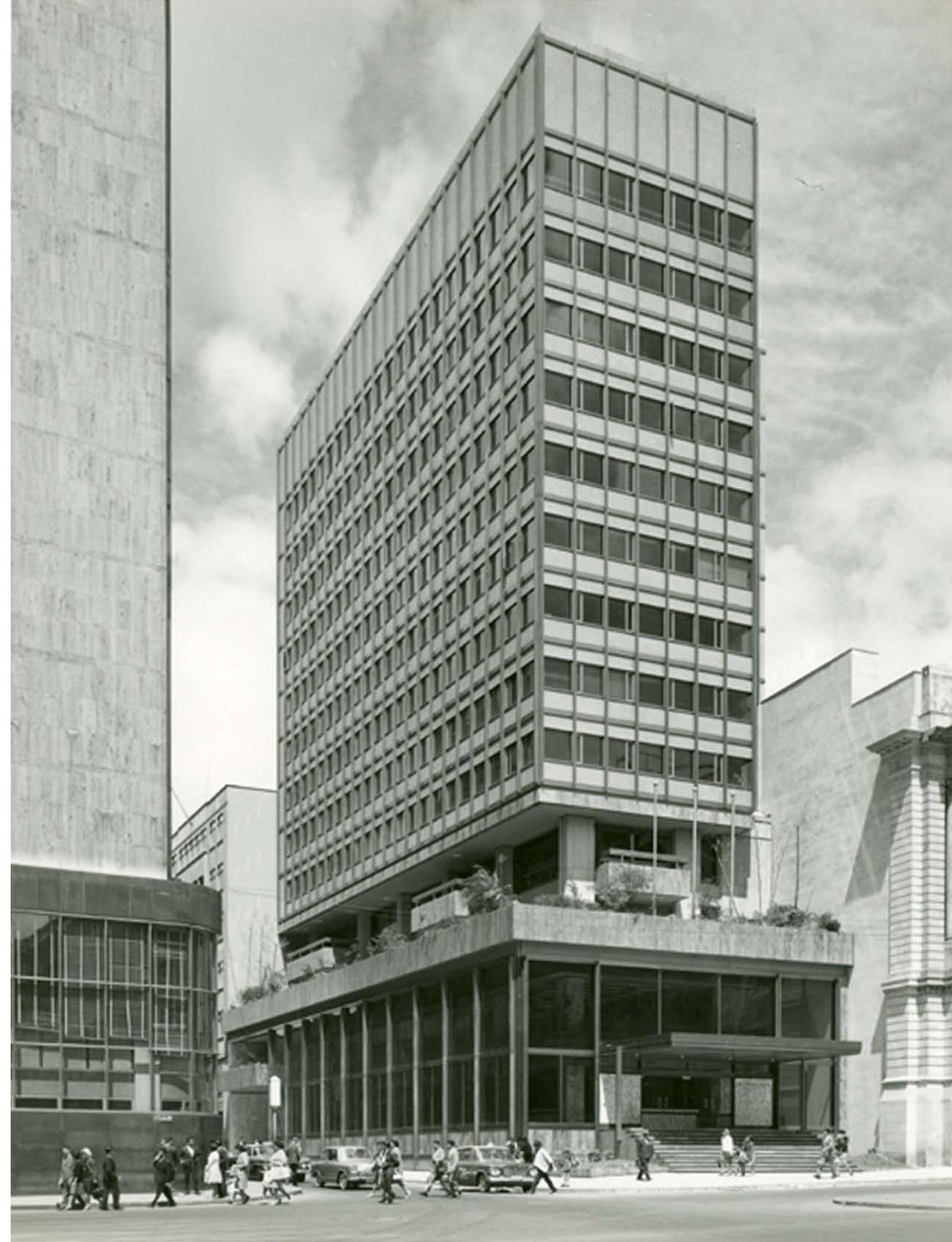
332 El montante se une de manera lateral al entrepiso logrando un contacto limpio entre las caras de ambos elementos; esto, sumado a que el antepecho pierde la condición de elemento sólido y opaco para establecerse como un paño más de vidrio transparente –que aporta a los requerimientos lumínicos de cada entrepiso–, permite considerar este caso como el más fiel a las características del *curtain wall*.
