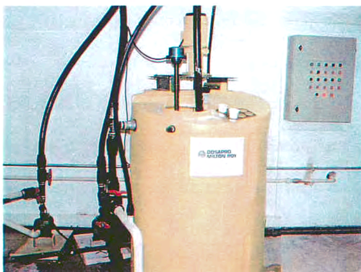
Figura 6.3. Se observa el reactor de precipitación con el cuadro de mandos a la derecha.
