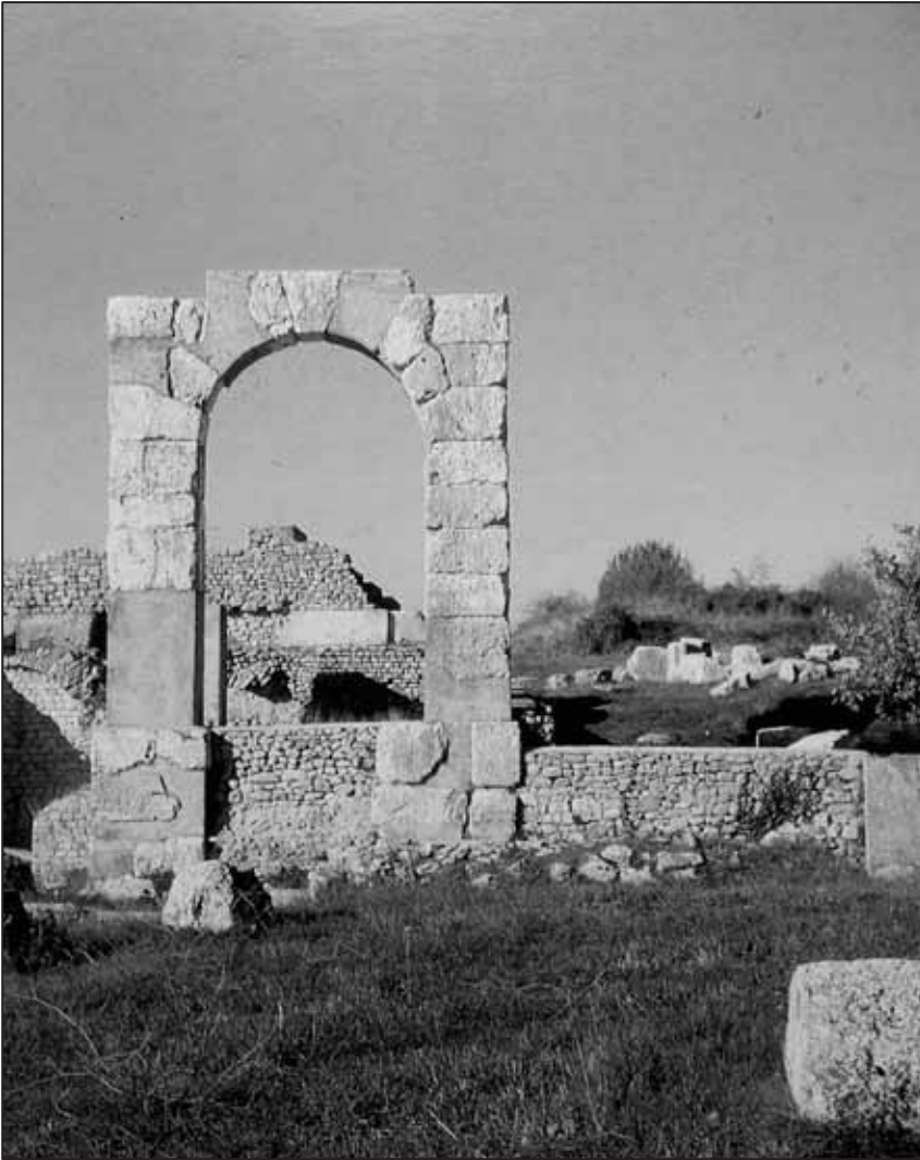
Figura 3. Tetrapilo meridionale e muro di separazione tra la via Flaminia e la piazza forense (da MORIGI 1997).
