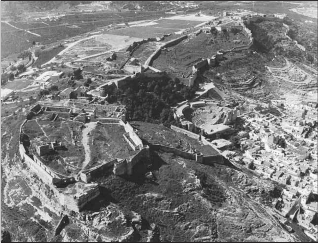
Figura 1. La città alta di Saguntum . Il complesso forense si trova in una posizione sopraelevata e decentrata rispetto all'impianto urbano, che si deve ad una continuità d'uso di una precedente area culturale. Il complesso doveva essere visibile anche da molto lontano e doveva colpire chi giungeva dal mare e da nord attraverso la via Augusta (fotografia aerea da RIPOLLÈS-LLORENS 2002).
