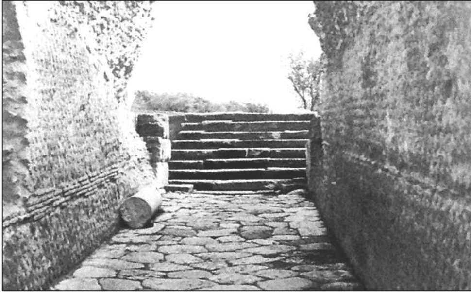
Figura 4. Il passaggio voltato e la scalinata che consentiva l'accesso alla piazza forense (da TAMBURINI 1998).
