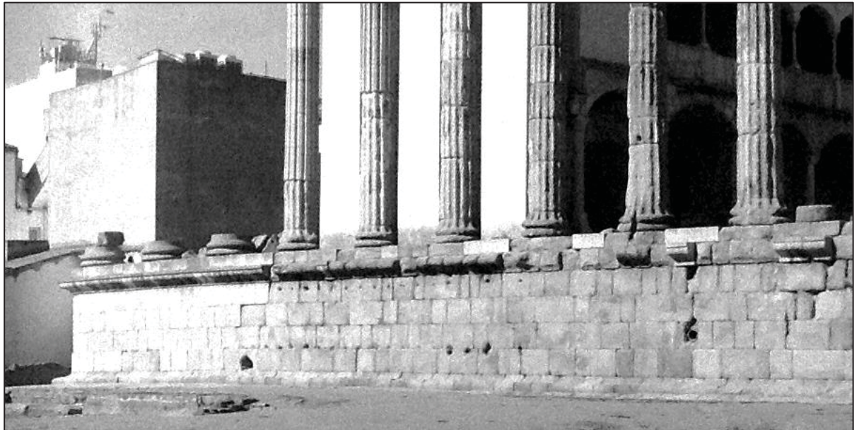
Figura 151. Augusta Emerita . Il lato lungo occidentale del podio del tempio, su cui sono visibili i fori che attestano il fissaggio di lastre marmoree (da STYLOW-VENTURA 2009).
