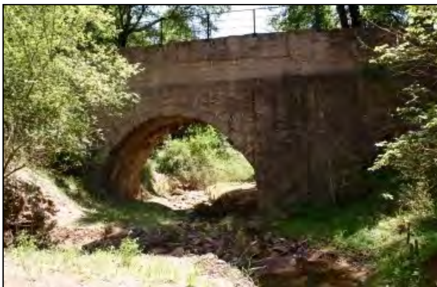
Figura 1.38. Aqüeducte del Mas de les Coves. Font: Centre de Documentació i Arxiu Històric de Can Font, Manresa.
