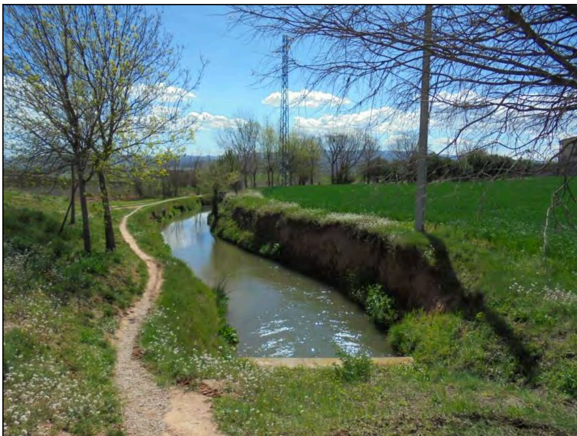
Figura 1.46. Secció típica excavada directament al terra. Imatge presa el juny de 2016.
