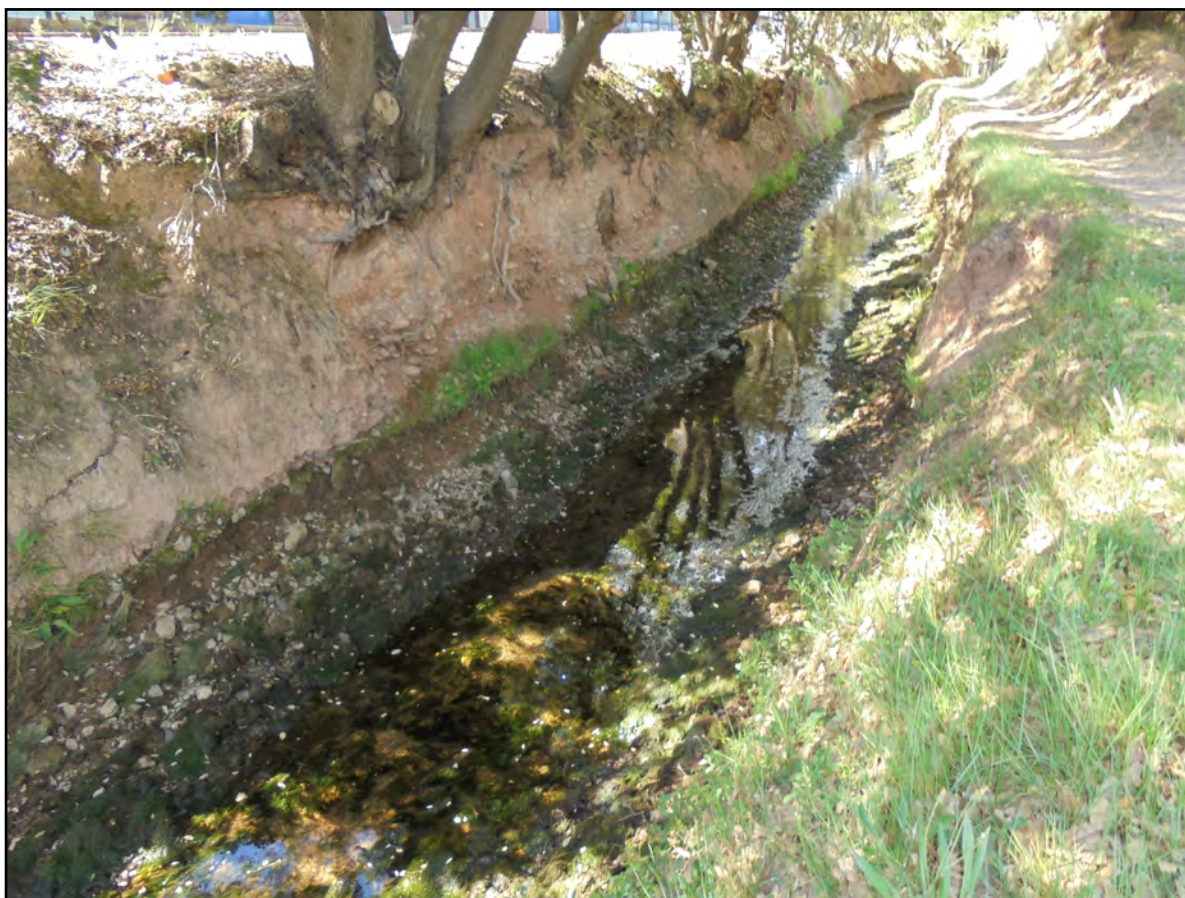
Figura 1.51. Tram del canal excavat al terra, buit per facilitar les tasques de manteniment i neteja. Imatge presa el juny de 2016.
