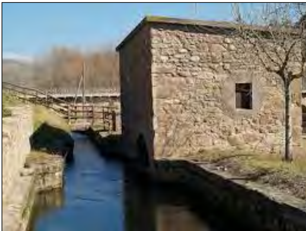
Figura 1.22. Caseta que conté el Mòdul Hidromètric. Font: CDAHCF.
