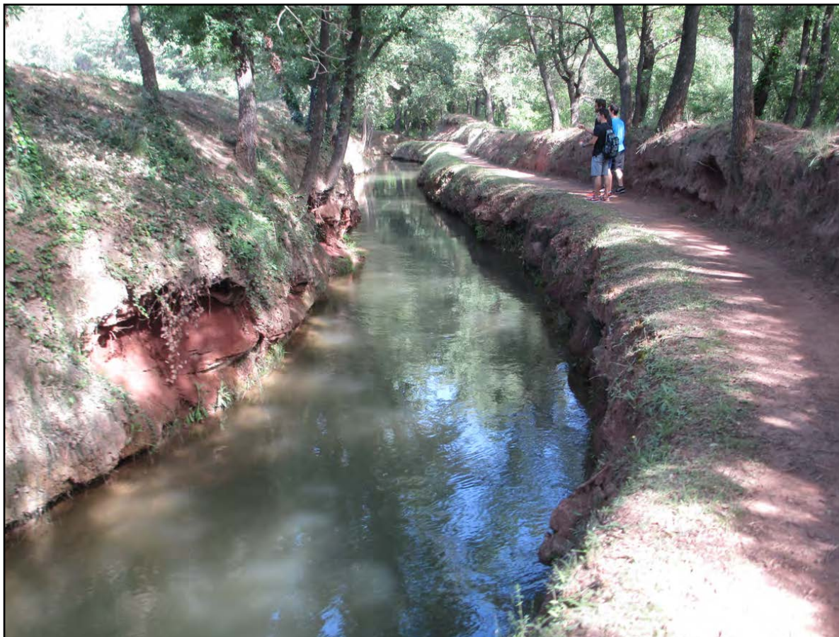
Figura 1.50. Tram del canal excavat al terra, al seu pas per Santpedor. Font: Centre de Documentació i Arxiu Històric de Can Font, Manresa.
