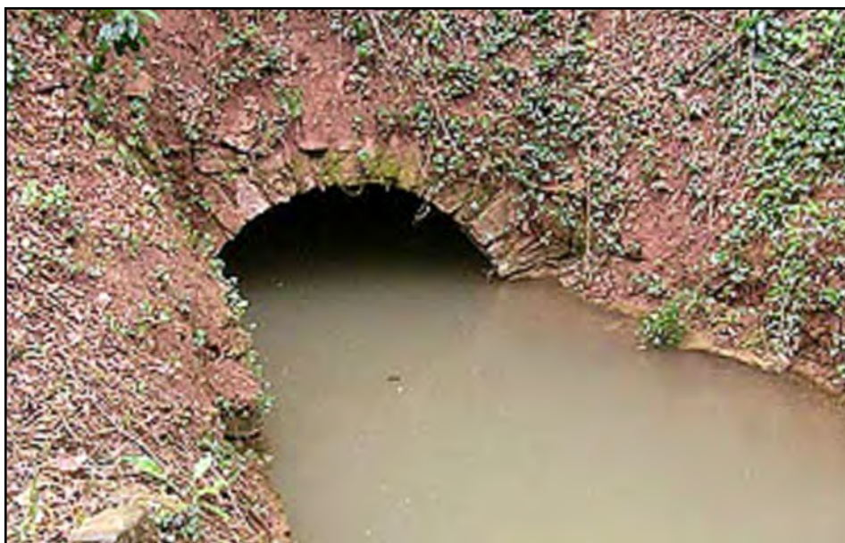
Figura 1.34. Entrada de la Sèquia a la mina del Mas de les Coves. Font: Lacenet, 2009.
