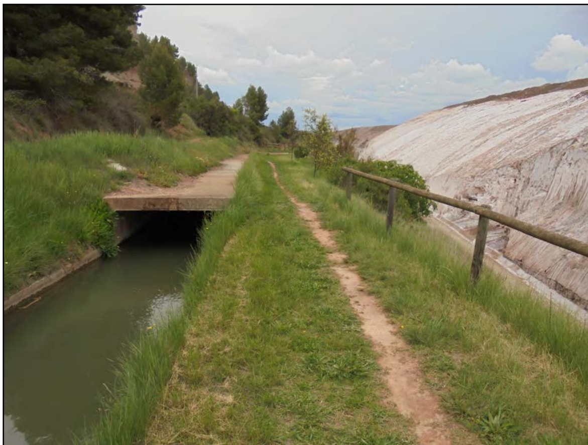
Figura 1.58. Soterrament de la Sèquia quan passa pel costat de l'escombrera de les mines de Sal-lent. Font: (Casafont Trench & Fitó Pintado, 2016).
