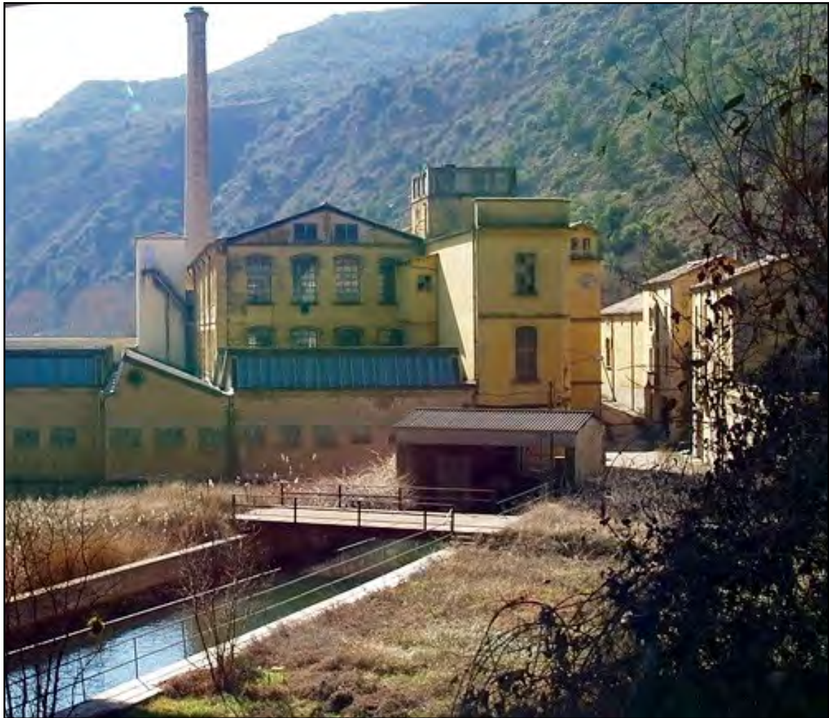
Figura 1.23. La fàbrica del Molí, amb el canal que alimenta la seva turbina. Aquí la Sèquia passa soterrada. Font: http://4.bp.blogspot.com/-E1stPSAmn5E/T1iQG6Rm40I/AAAAAAAAATpc/Eb_bRyYumww/s1600/P1010200a-1.JPG , data d'accés: 08/03/2016.
