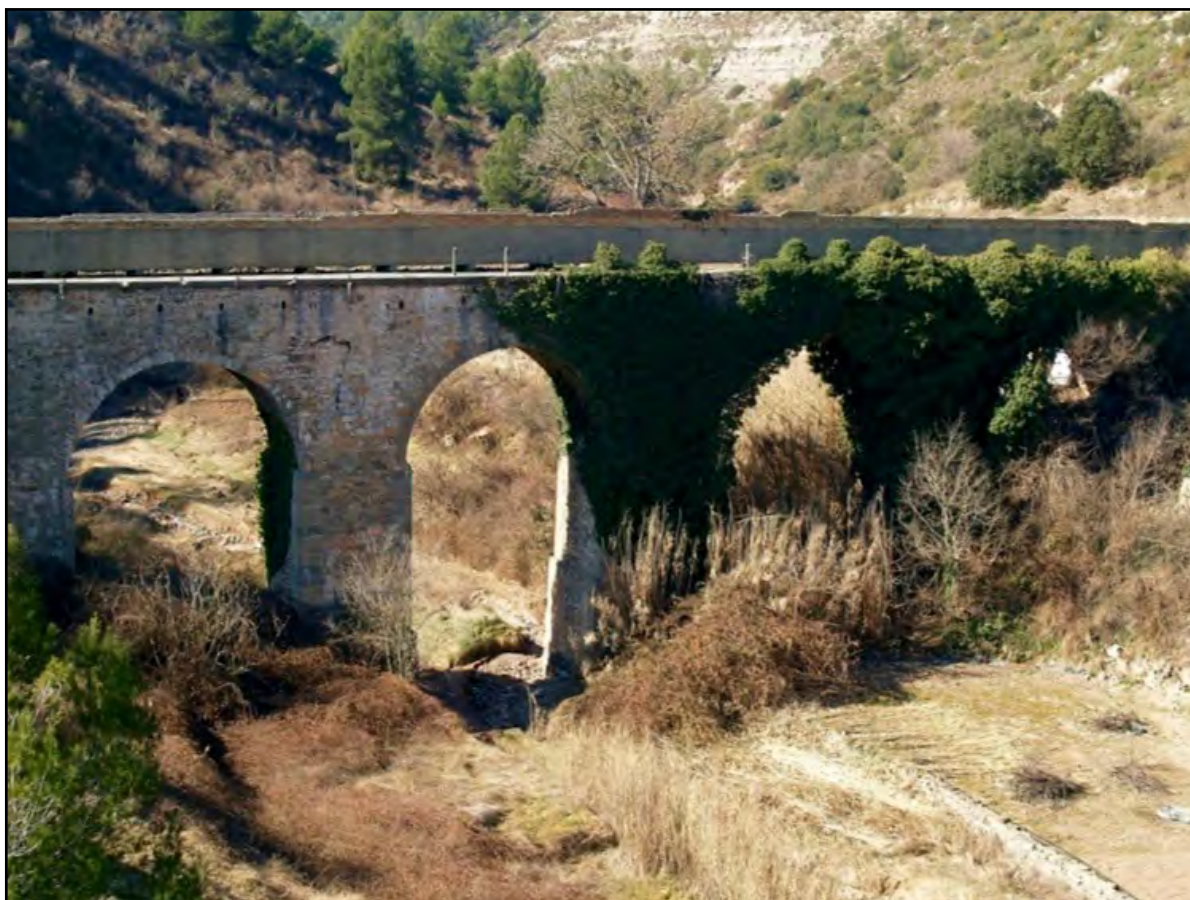
Figura 1.36. Aqüeducte del Vilar a Sallent, actualment fora de servei a causa de la subsidència del terreny. Font: http://losfolloneros.blogspot.com.es/2012/02/caminada-de-santpedor-balsareny-seguint.html , data d'accés: 08/03/2016.
