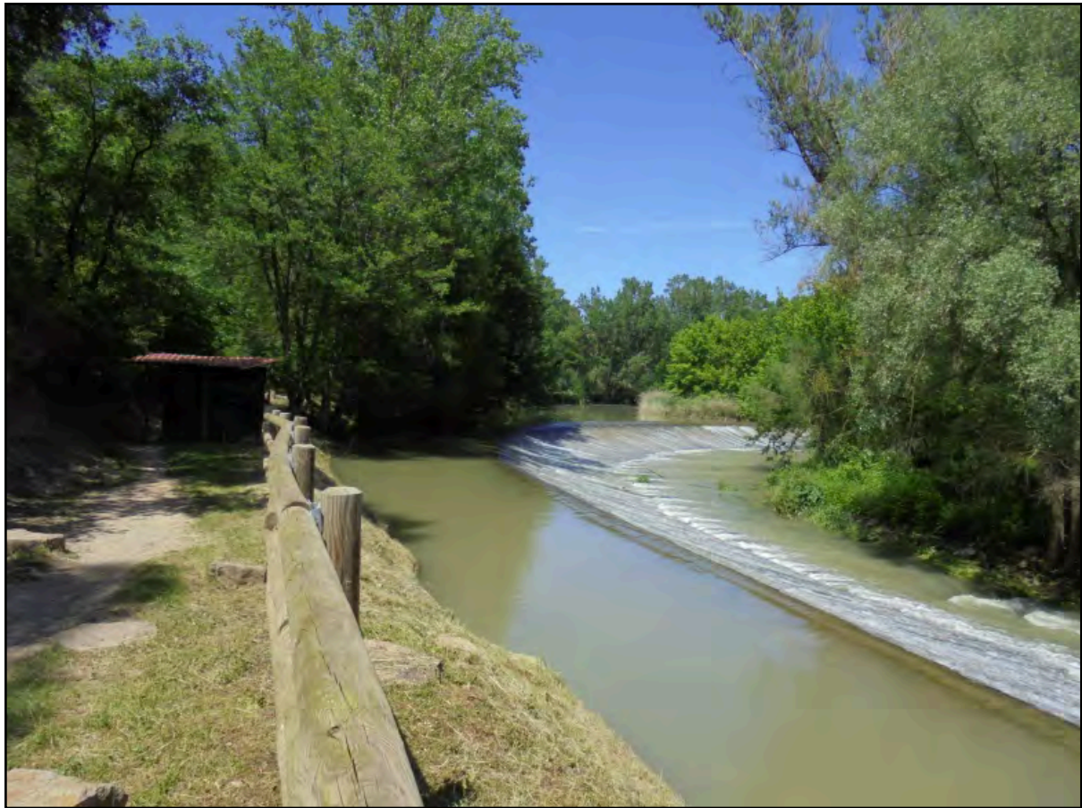
Figura 1.3. Imatge actual de la resclosa sobre el riu Llobregat, als peus del castell de Balsareny. Imatge presa el juny de 2016.
