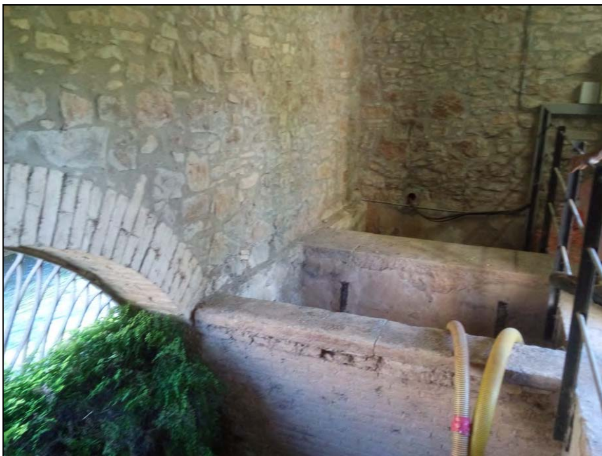
Figura 4.8. Interior de la caseta del Mòdul Hidromètric. Es poden observar el vessador lateral, protegit per una reixa, i les dos arquetes de regulació. En primer terme l'arqueta on hi ha la comporta de fons, en segon terme l'arqueta on es situava el flotador, al fons l'espai on es situava la canonada de descàrrega. Imatge presa el març de 2016.
