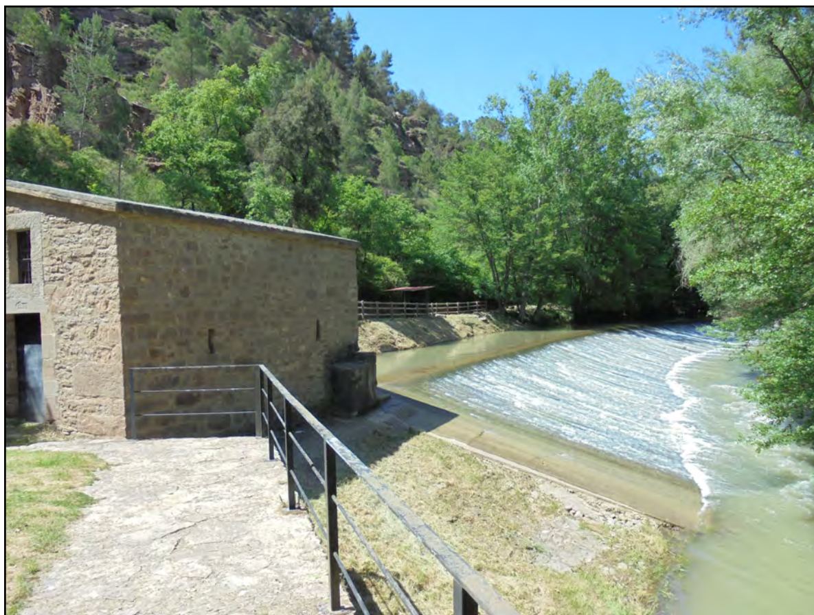
Figura 1.19. Imatge de la caseta de les comportes adjacent a la resclosa. Imatge presa el juny de 2016.
