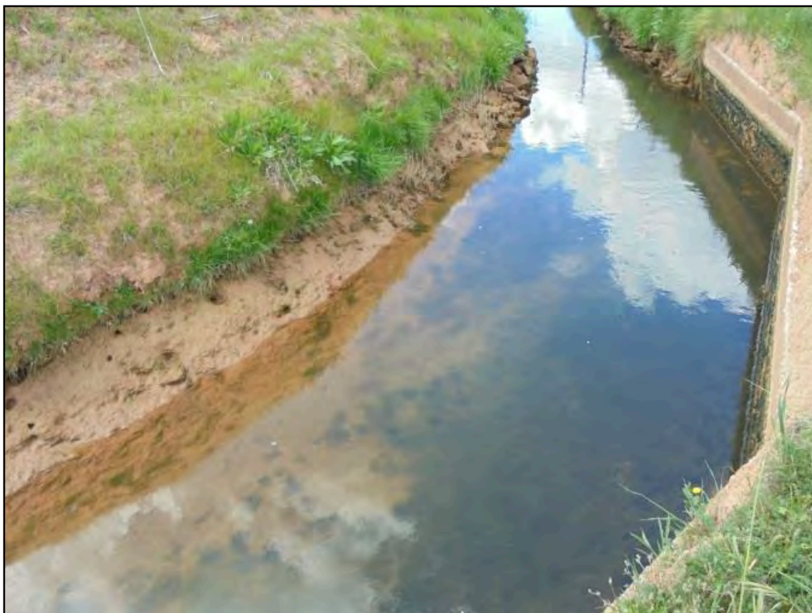
Figura 1.49. Secció mixta de terra i formigó, normalment present en corbes pronunciades. Imatge presa el juny de 2016.
