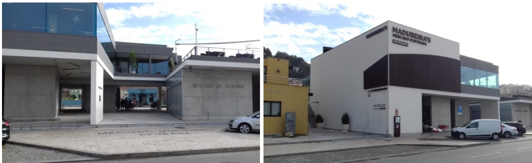
FIG. 49: Aspecto exterior del restaurante “Madureiras”. [Fotografías de la autora, 2018]
