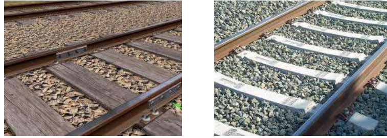
Figura 4.4: Imatge via travesses de fusta (esquerra) i travesses de formigó (dreta).
