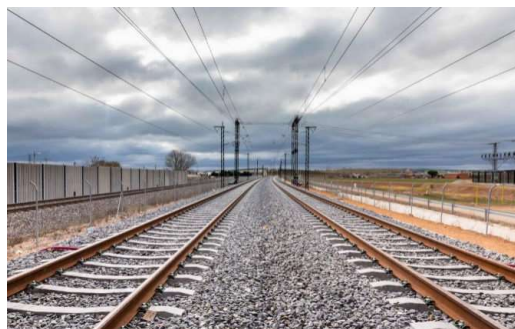
Figura 4.1: Via convencional de travesses i balast. [82]
