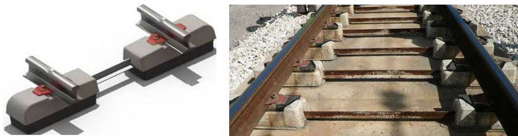
Figura 4.12: Detall sistema de fixació tipus STEDEF (imatge Esquerra). [83]. Fotografia detall via STEDEF (imatge dreta).
