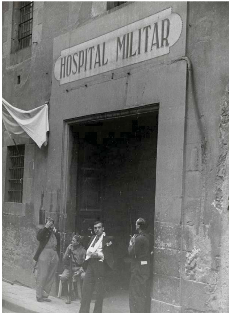
Il. 18. Pérez de Rozas, L'edifici de l'Hospital Militar al carrer Tallers abans de ser enderrocat , 29-X-1936. AFB, bcn006201
