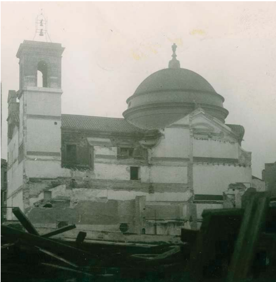
Il. 54. Juan Ramírez, Detall de la façana dreta de l'església de Sant Sever i Sant Carles Borromeu durant l'enderroc de l'hospital militar, 28-III-1943. AFB, C-038-185
