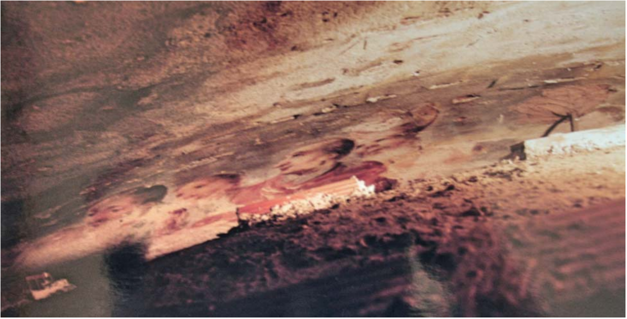
Il. 152. Josep i Manuel Vinyals (atrib.), Detall de la cúpula no visible (Sant Carles Borromeu vestit amb la musseta de cardenal) , c.1742-1752. Foto: Arcor, restauració de pintura s.l. (Mercè Marquès), 1999
