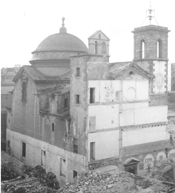
Il. 305. Juan Ramírez, Detall de la façana principal de l'església de Sant Sever i Sant Carles Borromeu durant l'enderroc de l'hospital militar, 28-III-1943. AFB, C-038-184
