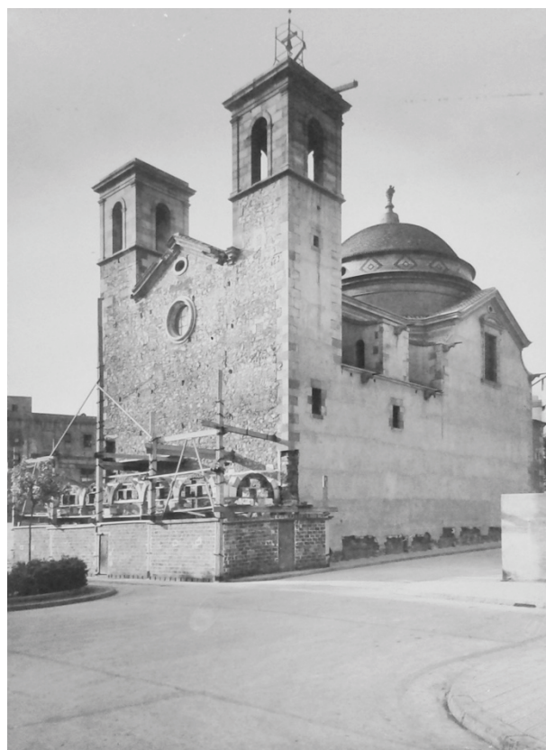
Il. 308. Francesc Ribera, Procés de construcció del pòrtic de l'església de l'ex-hospital militar, 25-VI-1948. AFB, Ribera, Urb_1389
