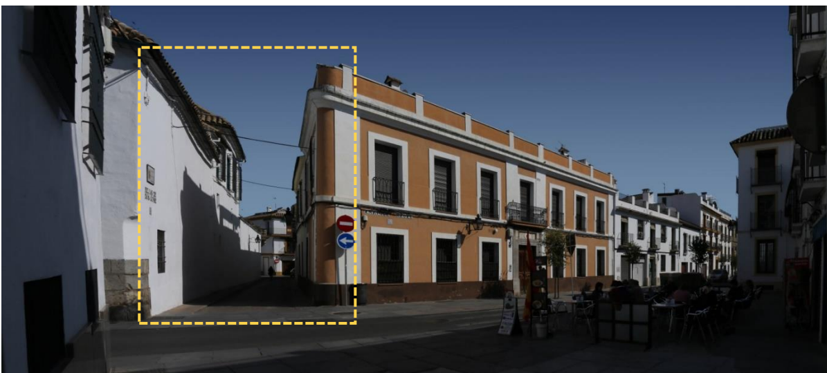
Figura 4. 35. Panorámica de la intersección de la Calle de las Rejas de Don Gome con la Calle Enrique Redel (22/02/2018)
