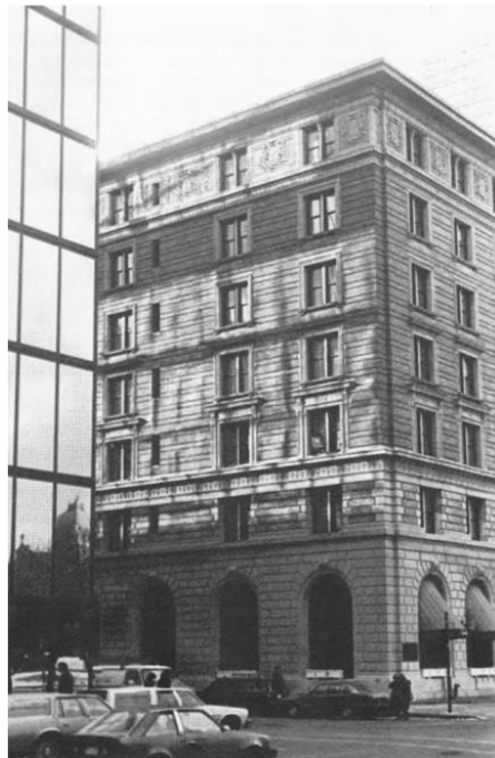
Figura 2. 4 Radiación reflejada sobre fachada. Fotografía tomada por V. Olgyay En: (Lam 1986)
