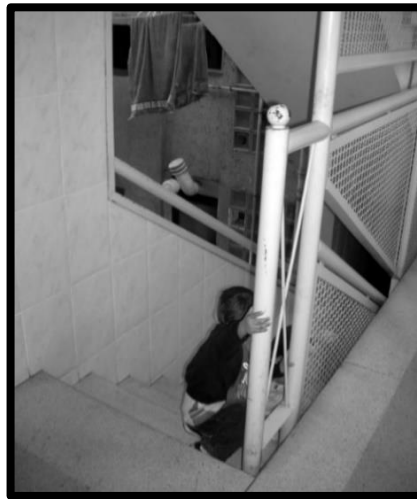
Interior de uno de los bloques de Sant Roc. Noviembre 2006
