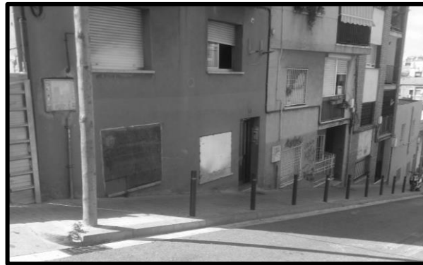
Vivienda cerrada con planchas metálicas. Santa Coloma de Gramenet, Agosto 2014
