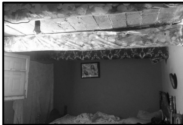
Interior de una vivienda ocupada en L'Hospitalet de Llobregat. Septiembre 2013.
