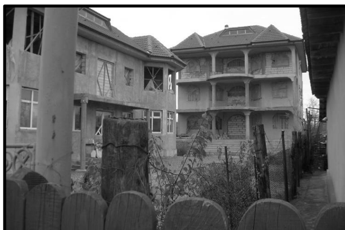
Vila en construcción. Țăndărei, noviembre 2007. Autora: Meritxell Sàez
