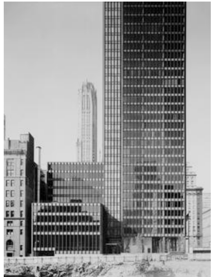
403. Vista del edificio desde la parcela vecina al noreste.
