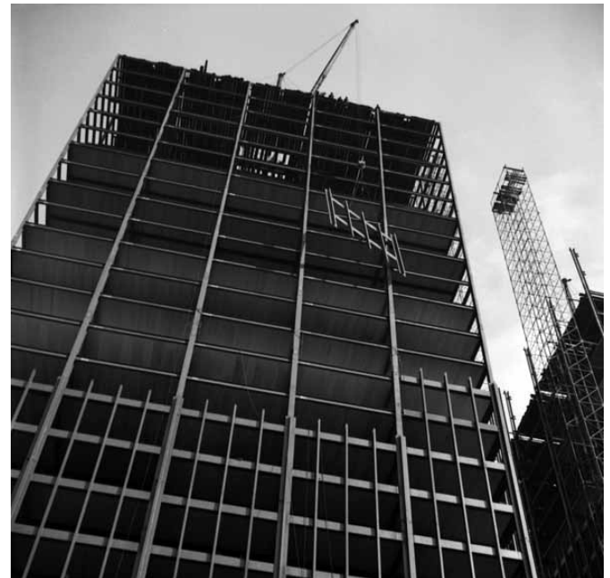
372. Colocación de los perfiles del muro cortina en los apartamentos 860-880 Lake Shore Drive. Chicago, 1948-1951.
