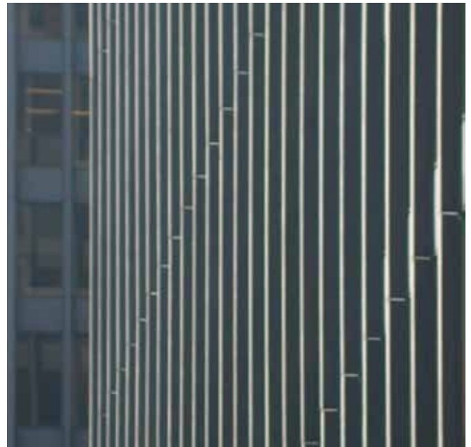
180-182. Vistas del muro cortina de las torres.
