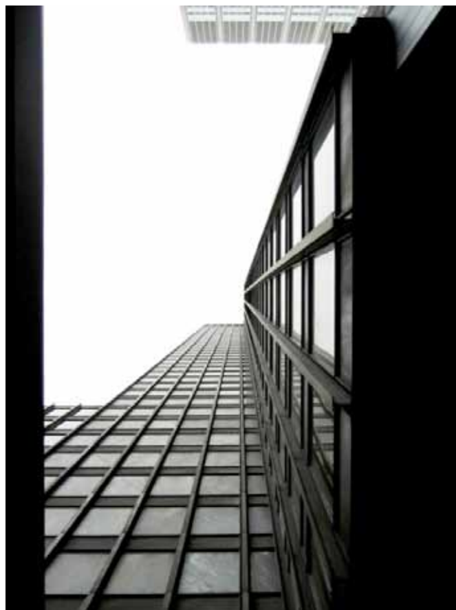
405. Detalle de los elementos que forman el edificio.
