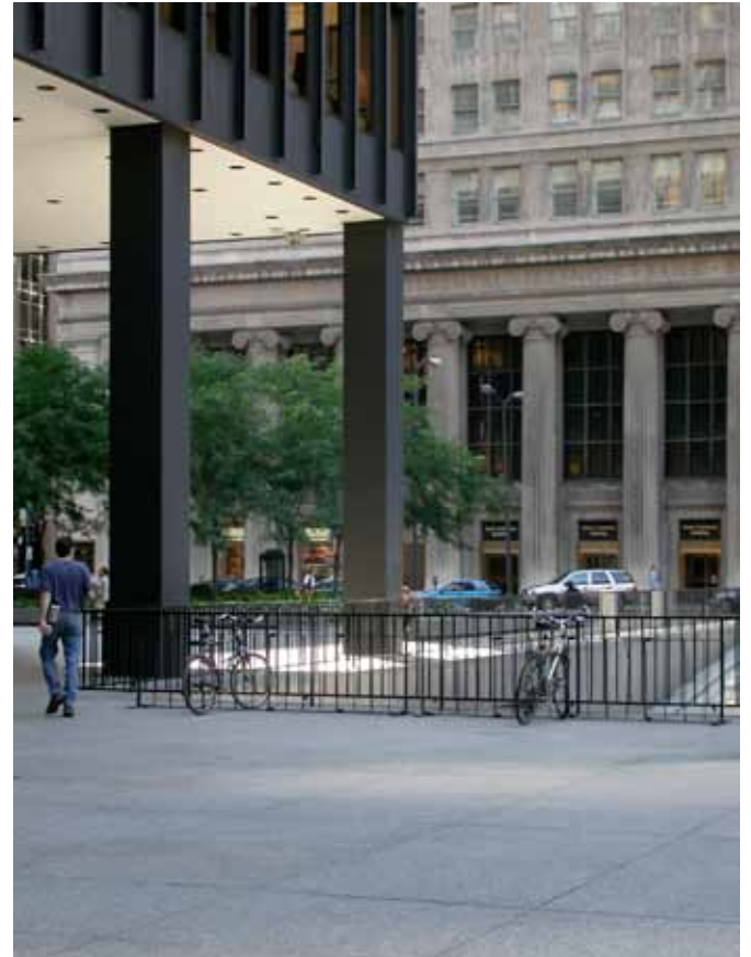
167. La planta baja de la torre de oficinas y la entrada el sótano vistos desde la plaza principal. Al fondo el edificio Bank of America
