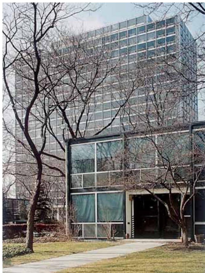
408-409. Vistas de la relación entre los edificios.
