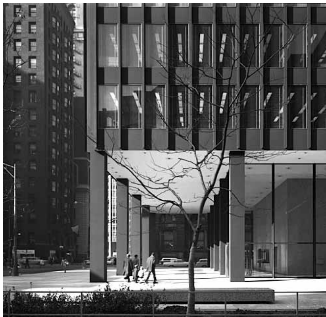
156. La planta baja de la torre de las cortes vista desde el este. Al fondo de la crujía abierta al exterior, el anterior Palacio Federal.
