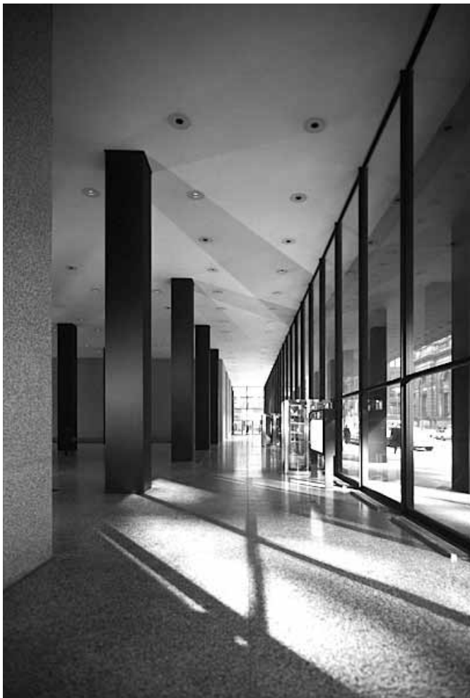
160. Interior de la planta baja de la torre de las cortes en la entrada desde la calle Dearborn.
