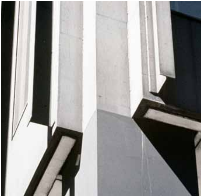
176. Detalles de las esquinas de las torres. A la izquierda la torre de las cortes, a la derecha la de oficinas.
