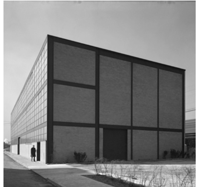
420. Edificio de Investigación de Minerales y Materiales del Instituto Tecnológico de Illinois. Chicago, 1942-1943
