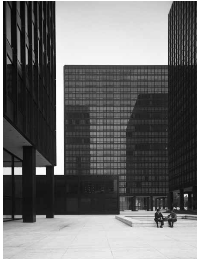
415. Vista de la relación entre los edificios del conjunto sobre el basamento.
