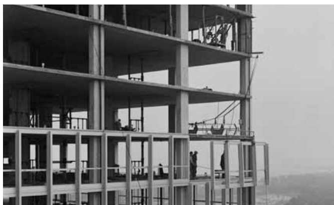
353. Colocación del muro cortina por delante de la estructura de hormigón en Commonwealth Promenade, Chicago, 1953-1956.
