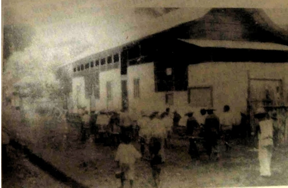
Fotografía 212: Niños del internado haciendo trabajos de reparación de infraestructuras urbanas
