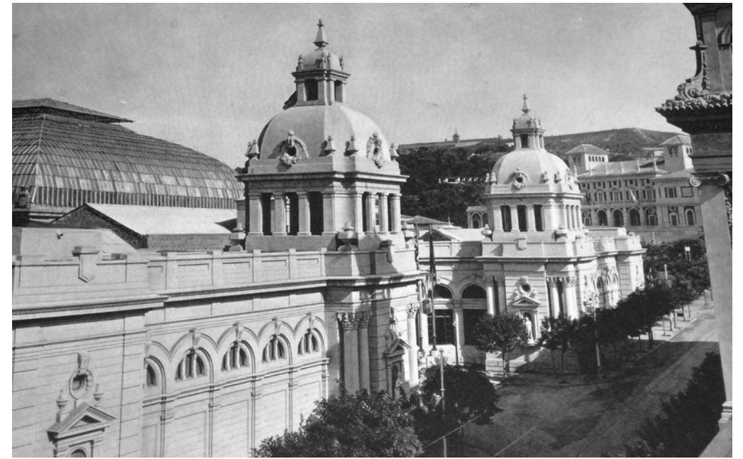
01 | Palau d'Arts Industrials Obra dels arquitectes Manel Casas i Manel Puig i Janer.
