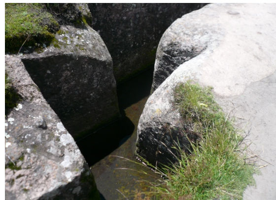
Foto 3: Particular del canal
