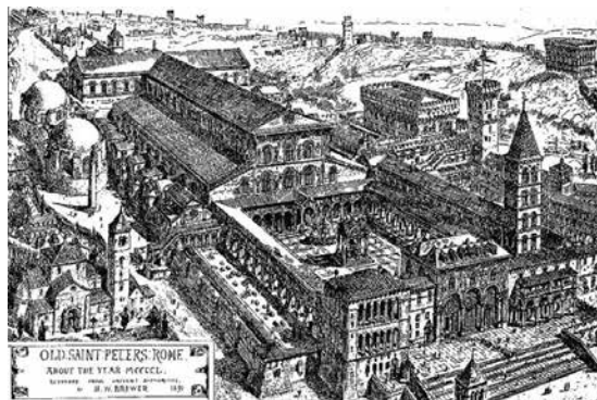
FIG. 1.13. Pio II en 1462, emite un reglamento en contra de la destrucción de monumentos antiguos y al mismo tiempo ordena la reconstrucción de San Pedro de Roma en 1505. En las imágenes: San Pedro de Roma, primer edificio de 1450 y el nuevo edificio de 1630. Fuente: Grabado: R.H.W. Breweren 1891. Pintura: Viviano Codazi.
