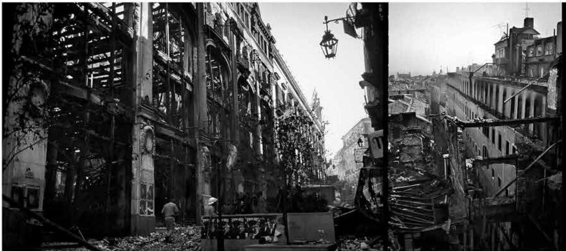
El Chiado 1988, estado posterior al incendio Fotografías: Rui Lebreiro Enriquez
