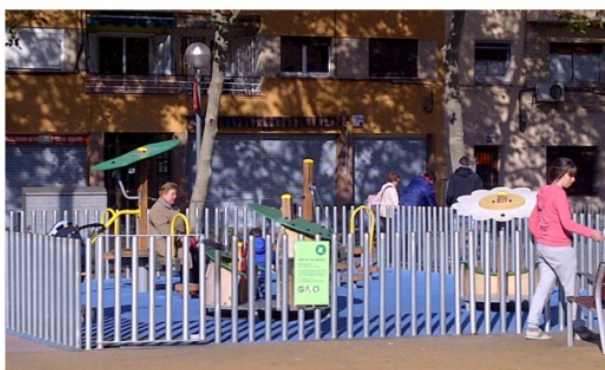
Figura 104. Impermeabilización e instalación de juegos infantiles sobre el Casal de Barri Fuente: elaboración propia, febrero de 2012.
