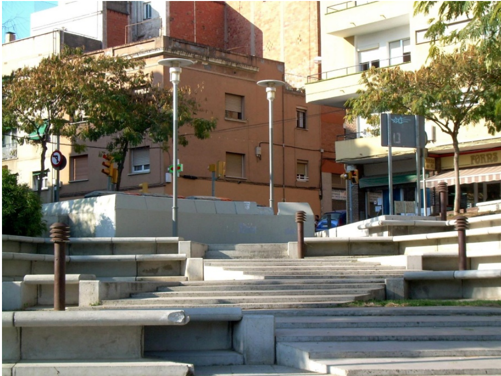
Figura 84. Detalle de los escalones de acceso de la plaza Ángel Pestaña sobre la calle de Santa Engracia Fuente: elaboración propia, junio de 2008.
