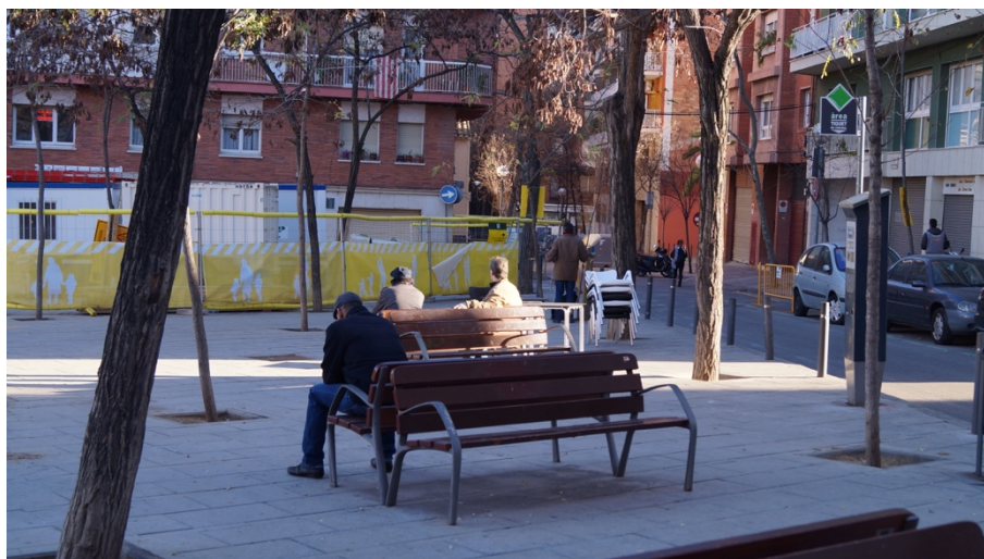
Figura 73. La plaza Can Robacols en obras, enero de 2015 Fuente: elaboración propia.
