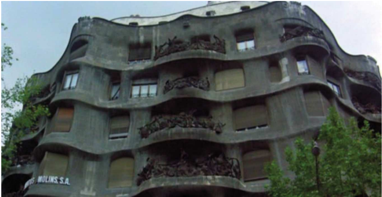
Figura 21. The Passenger (1975). La fachada de La Pedrera.
