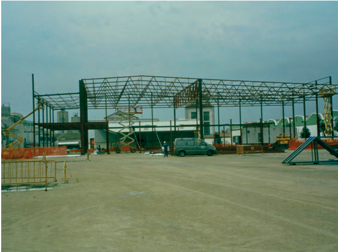
14. Obres d'ampliació iniciades a l'any 2000.
