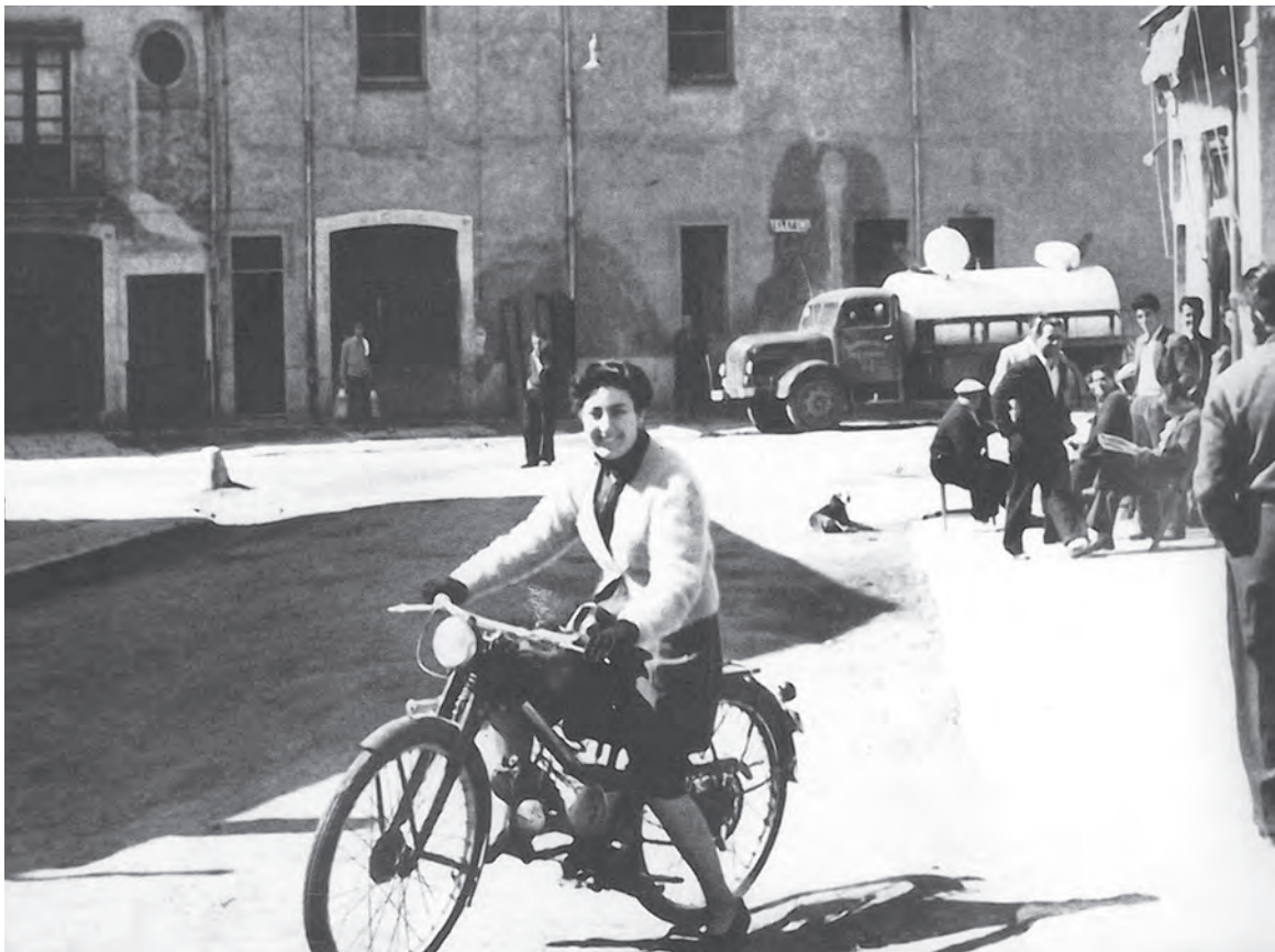
2.Cisterna davant de la façana de les instal·lacions de "Comp. Moragas-Madí S. en C." a Sils.
