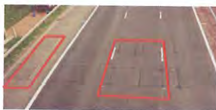
Bucles bajo la calzada de la autopista M-45 de Madrid.
