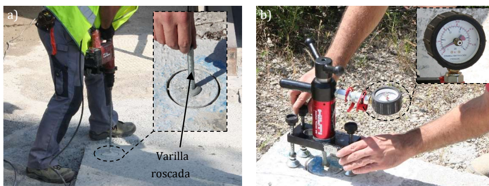
Figura 5.18 – Ensayo de Pull-Off: taladro y colocación de varilla (a) y equipo utilizado (b).
