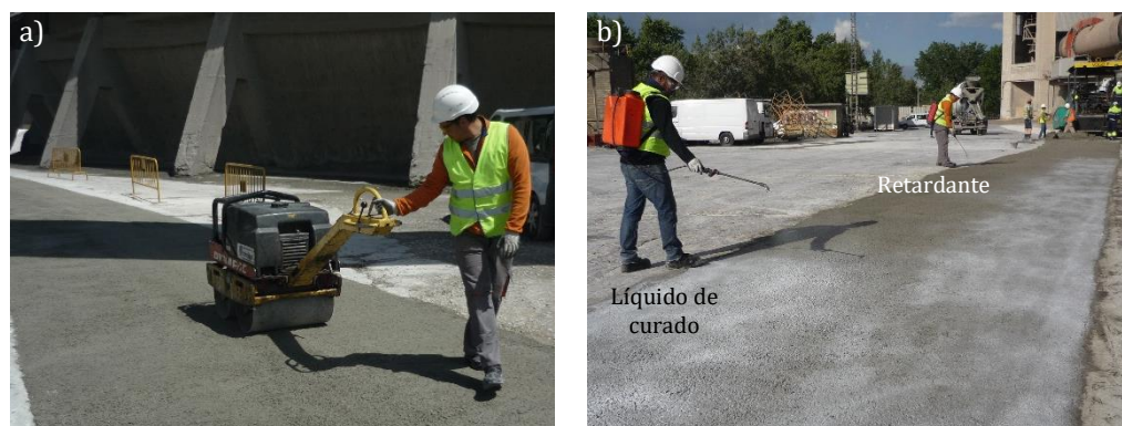
Figura 6.12 – Experiencia 2: Compactación del firme (a) y aplicación del retardante y curado (b).
