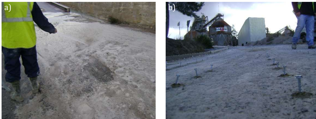
Figura 5.21 – Construcción de la Experiencia 1: lavado de la zona (a) y detalle de los tornillos (b).
