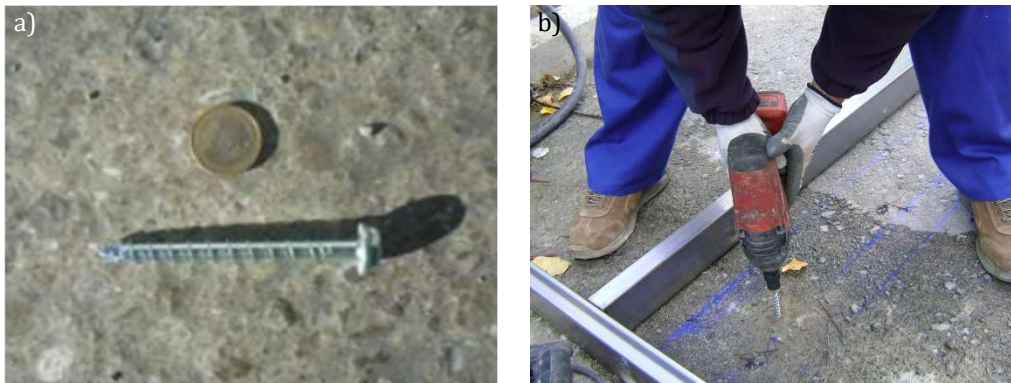
Figura 5.11 – Tornillo HILTI HUS-H 6x80/25/45 (a). Colocación del tornillo en el pavimento (b).
