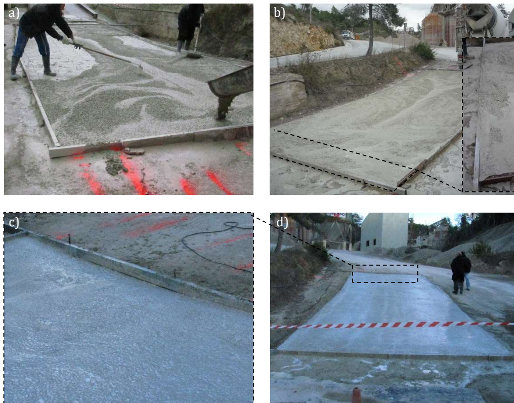
Figura 5.23 – Hormigonado de la Experiencia 1 (a). Detalle antes de vibrar de la zona próxima a la báscula (b). Detalle de la pérdida de espesor en la parte superior (c). Aspecto tras la aplicación del producto de curado (d).
