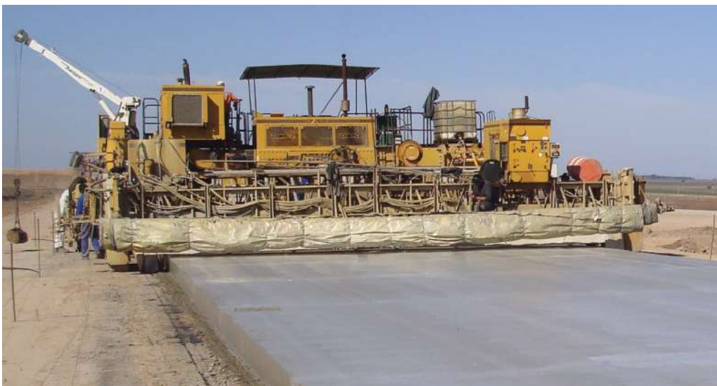
Figura 2.9 – Extendidora de encofrados deslizantes (ICPA, 2014).
