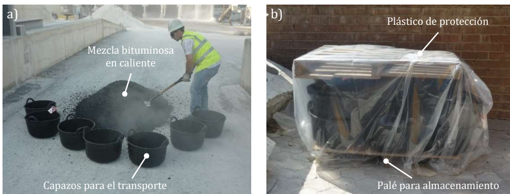
Figura 4.9 – Recogida en planta del A (a) y almacenamiento hasta la producción de las probetas (b).
