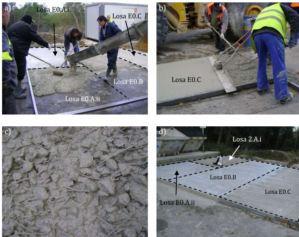
Figura 5.16 – Vertido del hormigón en la losa E0.A.ii (a), compactación con regla vibrante (b), hormigón de las losas E0.A.ii y E0.B en estado fresco (c) y aspecto de las losas tras el curado (d).
