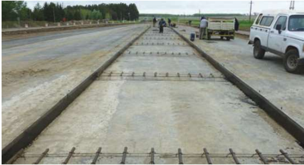
Figura 2.10 – Construcción con encofrado fijo (ICPA, 2014).
