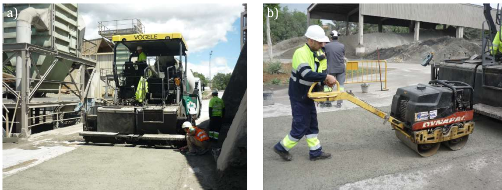
Figura 5.29 – Construcción de la Experiencia 2: extensión del hormigón (a) y compactación (b).
