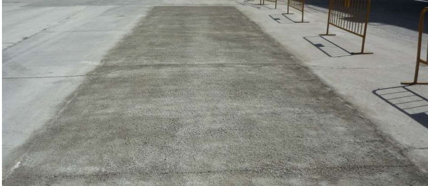
Figura 1.1 – Pavimento de hormigón
