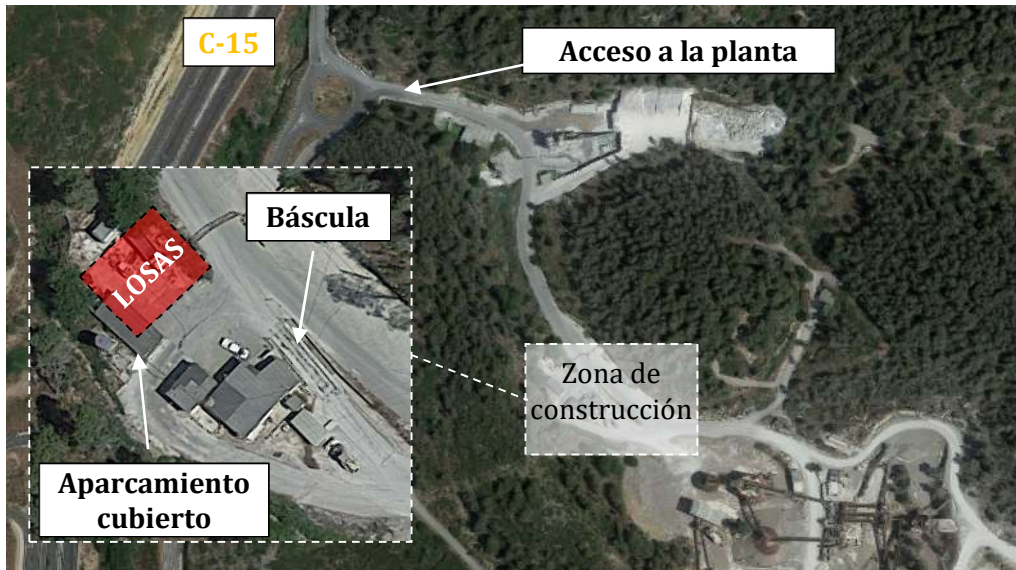
Figura 5.12 – Emplazamiento de las losas en el interior de la planta.
