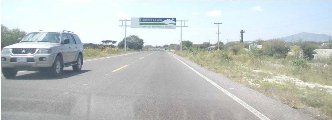
Carretera MEX120 en el municipio de Cadereyta de Montes 504
