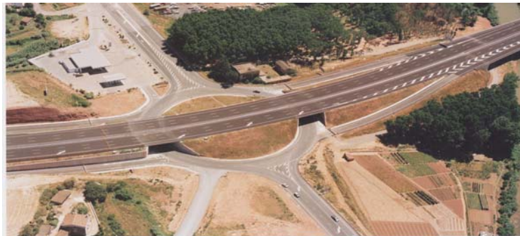
Enlace del Eix Transversal con la vía C-55, municipio de Manresa 143
