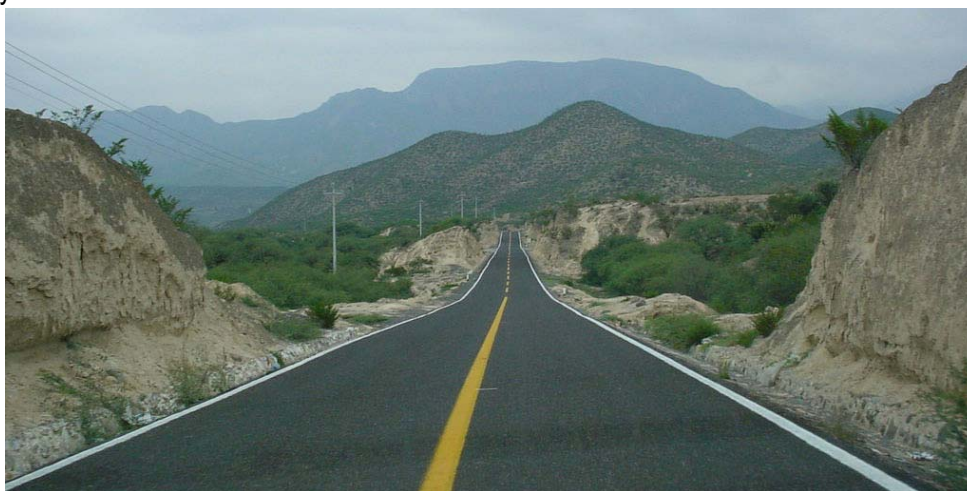
Carretera MEX120 a su paso por el municipio de Peñamiller 505
