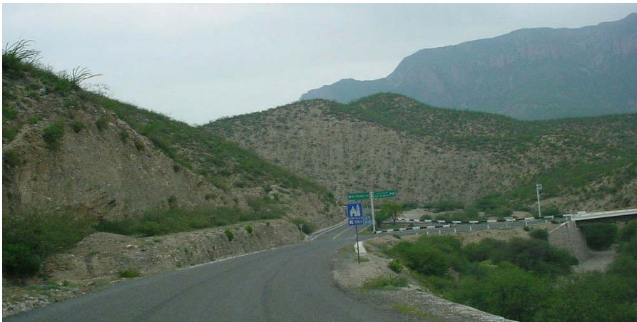
Carretera MEX120 a su paso por el municipio de Peñamiller
