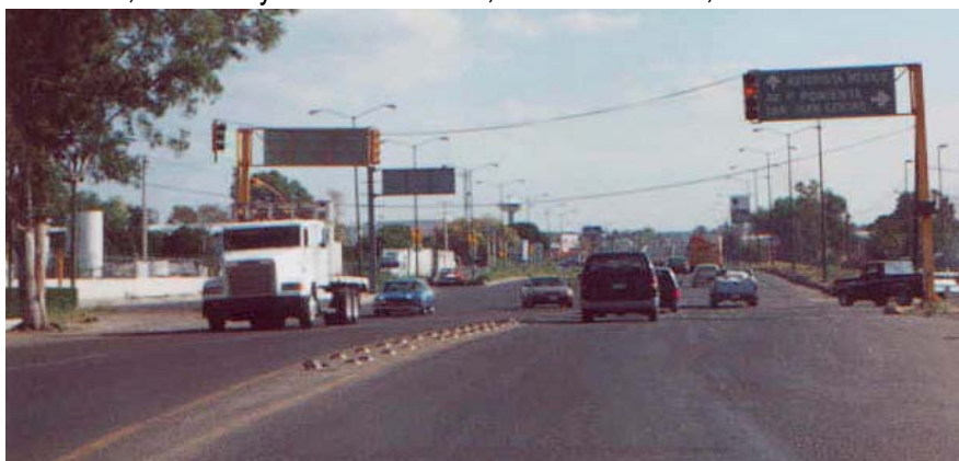
Carretera MEX120 a su paso por la zona industrial de San Juan del Río 534
