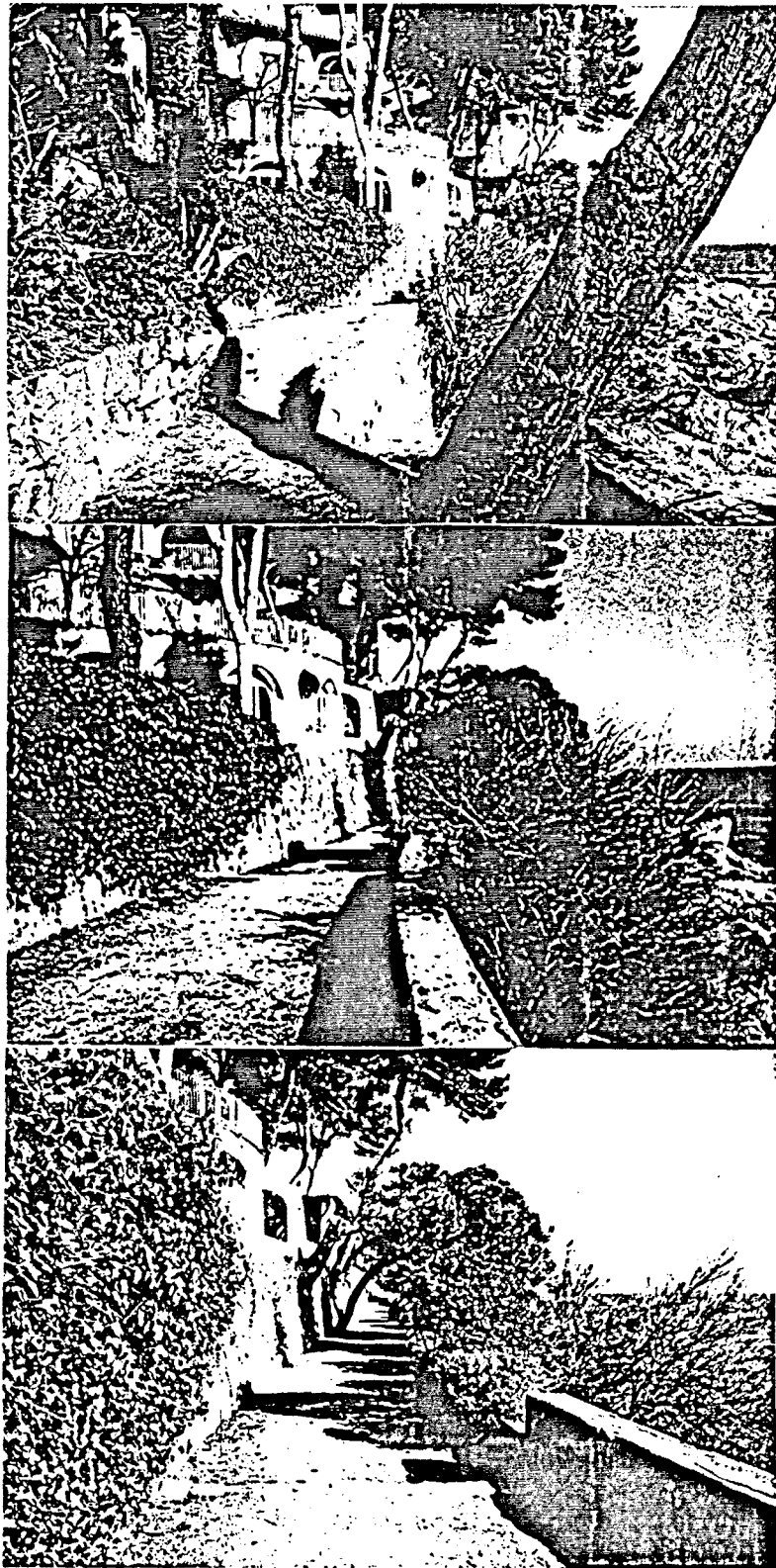
TRAM 9. Sector consolidat, camí relacionat amb les edificacions veïnes. Foto 124, Foto 125, Foto 126.
