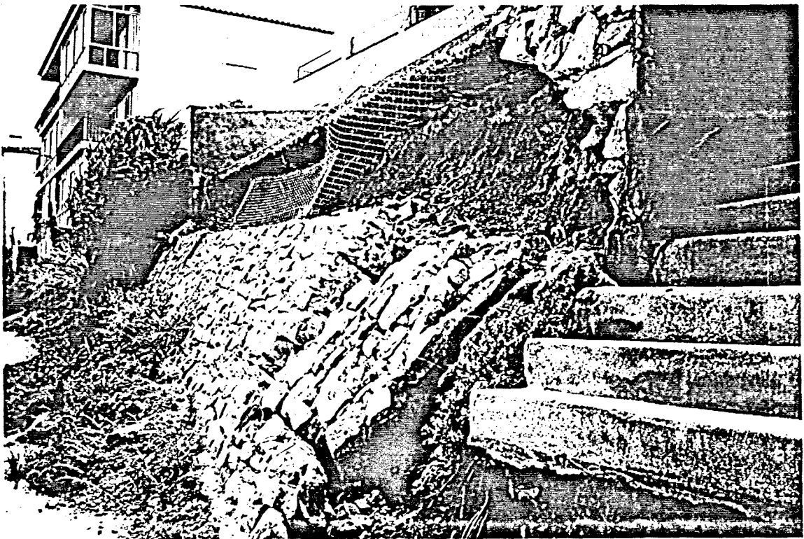
Figura 9.103: Foto de patologia per la manca de desguàs en els murs de contenció laterals. Fané. Llançà.
