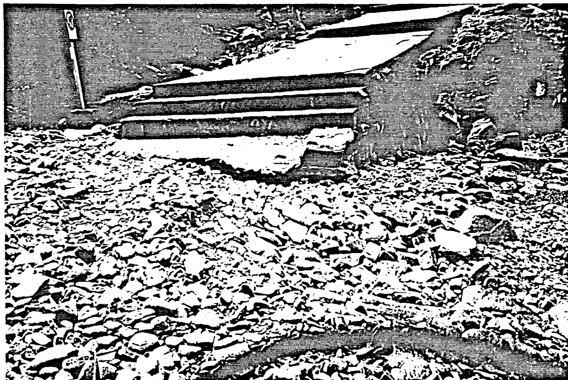
Figura 9.98: Foto de l'acció del mar damunt del C.R. a la Platja del Pas a Port de la Selva, de recent construcció.
