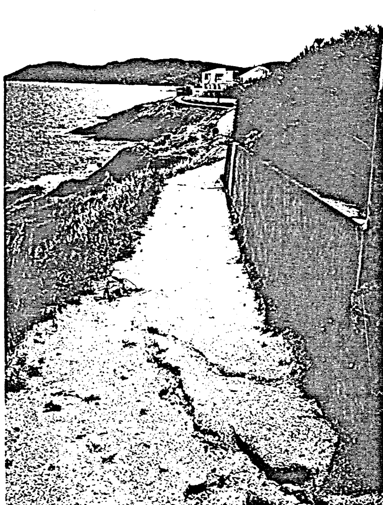
Figura 9.102: Foto de patologia per la no conducció de les aigües de pluja al paviment del camí. Fané Llançà.
