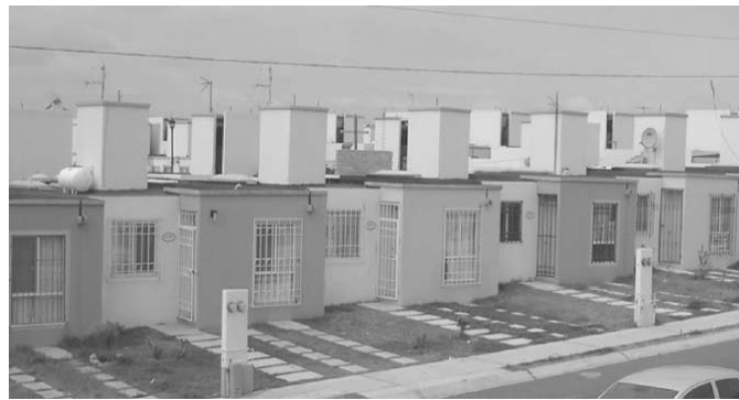
Figura 2.79 Edificios con muros delgados en México [Carrillo, 2009]
