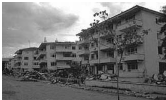
(a) Colapso de edificios porticados
