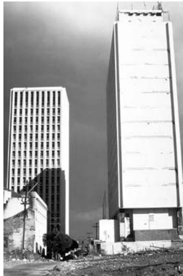
Figura 2.60 Vista general de los edificios del Banco de América (izquierda) y del Banco Central de Nicaragua (derecha)
