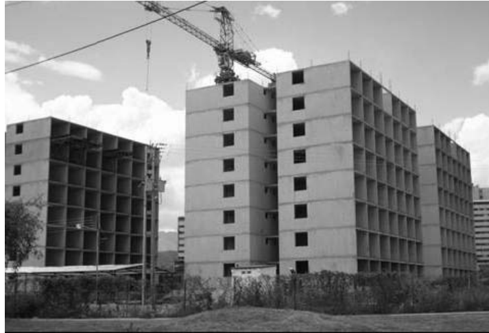
Figura 2.78 Edificios con muros delgados en Venezuela [www.skyscrapercity.com]
