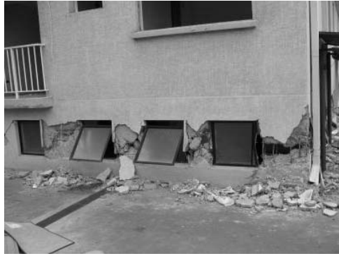
Figura 2.69 Edificio de muros con aberturas en Chile [Foto: Diego Lopez-García, 2010]
