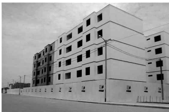
(a) Edificio con muros continuos en altura
