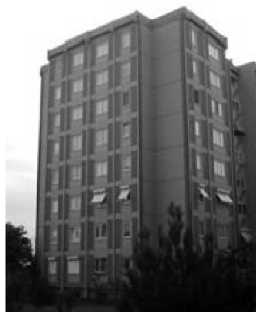
(b) Edificio con encofrado túnel
