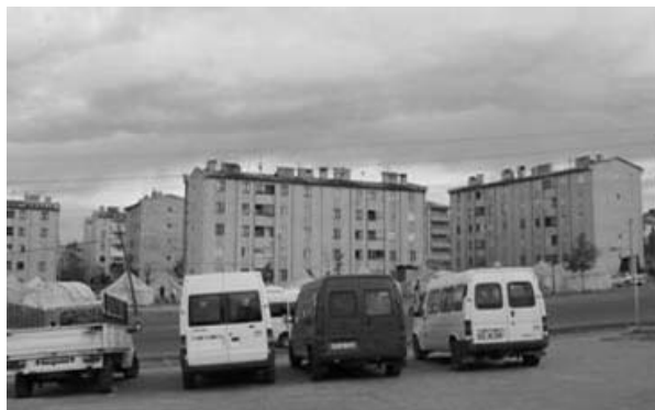
Figura 2.67 Edificios con pantallas en Turquía
