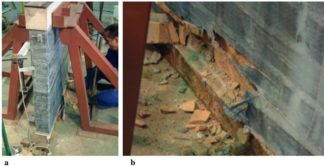
Figura 4.48 — Ensayo del panel 12: (a) vista lateral del panel ensayado; (b) detalle del aplastamiento.
