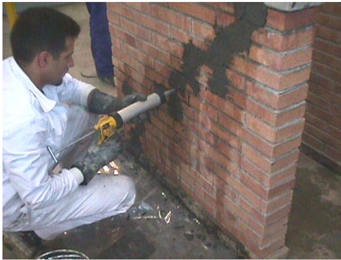
Figura 3.16 — Aplicación del mortero tixotrópico base cemento en las juntas verticales.
