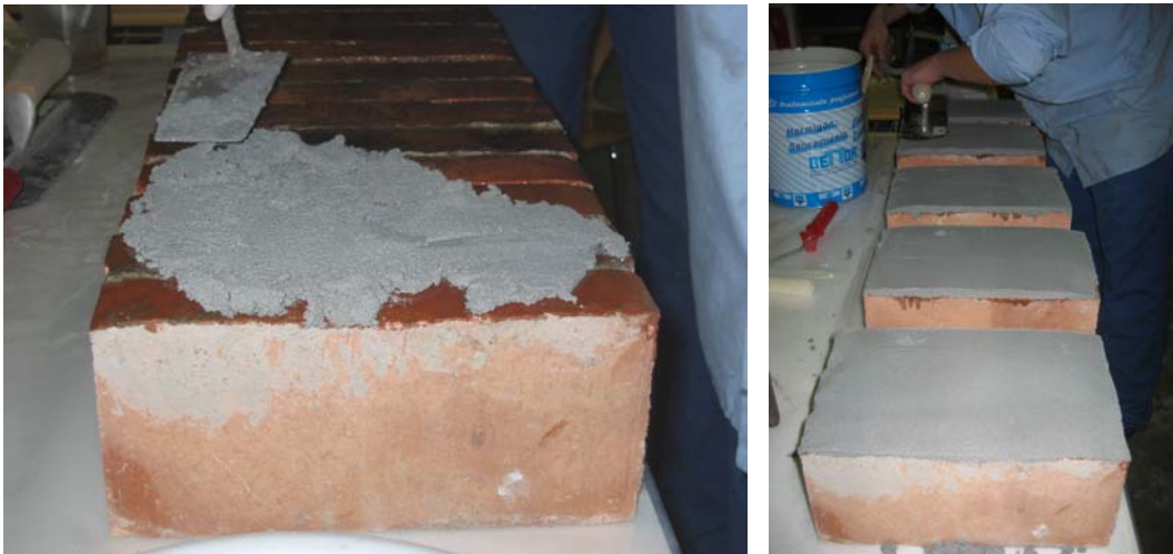
Figura 3.63 — Aplicación del mortero de regulación en la superficie: (a) Utilización de una paleta para albañilería (b) apariencia final.
