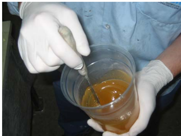
Figura 3.55 — Imprimación de resina epoxi.
