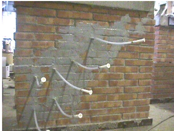
Figura 3.23 — El panel 7 durante la preparación para inyección de resina epoxi.
