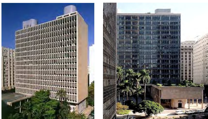
Figura 4.44 - Fachadas del MES: norte con el brise y sur con curtain wall y pilotis. Fuente: WISNIK, 2001.
