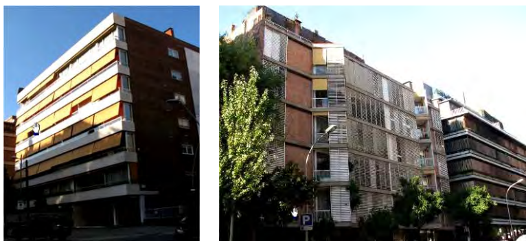
Figura 1.37 – Toldos y pantallas con venecianas protegiendo los balcones en Barcelona. Fuente: acervo del autor.
