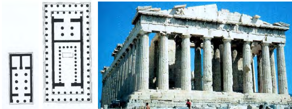
Figura 1.14 - En el Páternon, la transformación desde el megaron hasta el templo griego y las columnas como protectores solares. Fuente: BEHLING & BEHLING, 2002.
