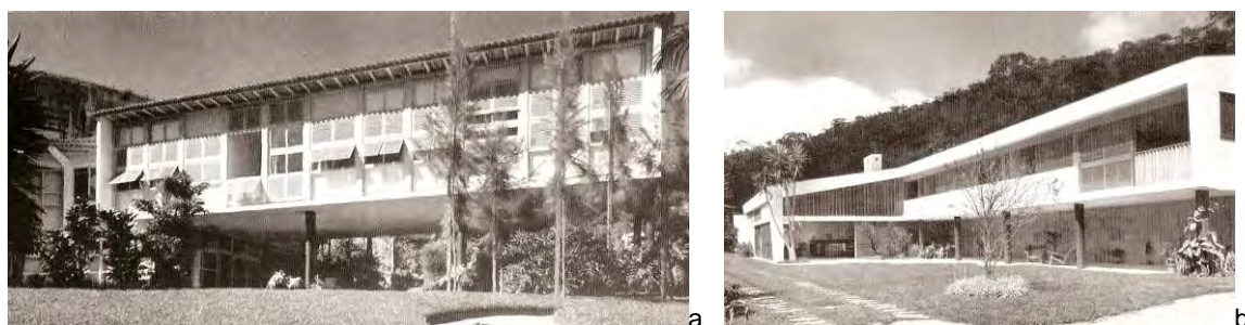
Figura 4.68 - Casa de campo George Hime (Henrique Mindlin, 1949) (a); Casa Geraldo Baptista (Olavo Redig de Campos, 1954) (b). Petrópolis. Fuente: MINDLIN, 1956.
