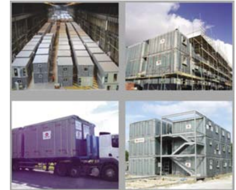
Edificios modulares ligeros. Sistema de gestión integrada (Corus). Fabricación, transporte, montaje, mantenimiento y desconstrucción.
