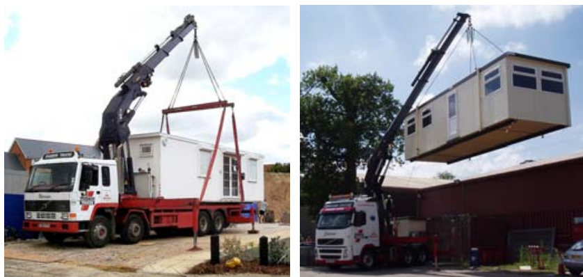
Camiones grúa izando módulos de medidas similares a las consideradas (2,44 x 9,00m)
