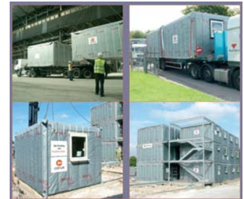
Edificios modulares ligeros. Sistema de gestión integrada (Corus). Fabricación, transporte, montaje, mantenimiento y desconstrucción.
