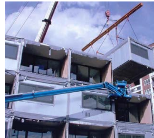
Módulos adaptados Yorkon para un edificio de viviendas. Reino Unido.
