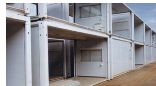
Módulos estándar a la espera de ser rehabilitados para su uso en escuelas temporales. Sant Andreu de la Barca, España.
