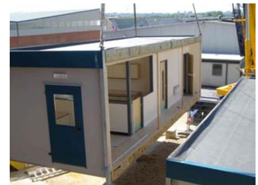
Montaje de una vivienda modular fabricada por la empresa inglesa Rollalong Limited.
