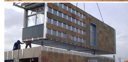
Módulos adaptados Modultec para un edificio escolar. España.
