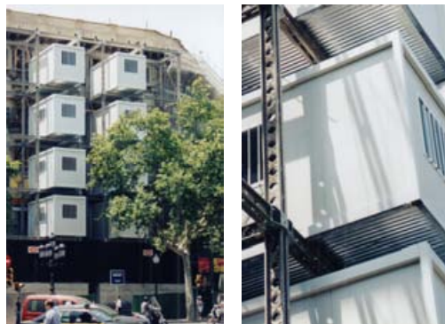
Módulos estándar Washington Internacional en un edificio en rehabilitación. Barcelona.
