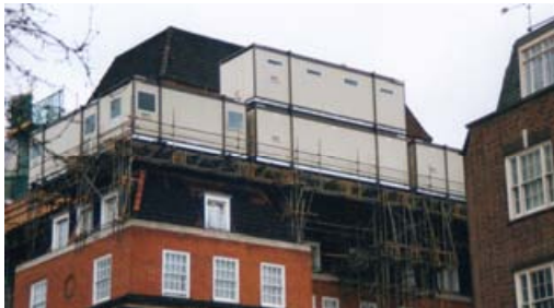
Módulos estándar sobre un edificio en rehabilitación, Londres.
