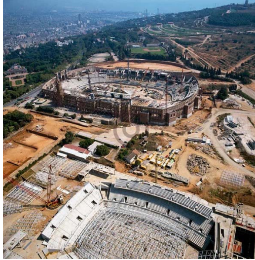
Imagen 5.10. Construcción de del Anillo Olímpico
