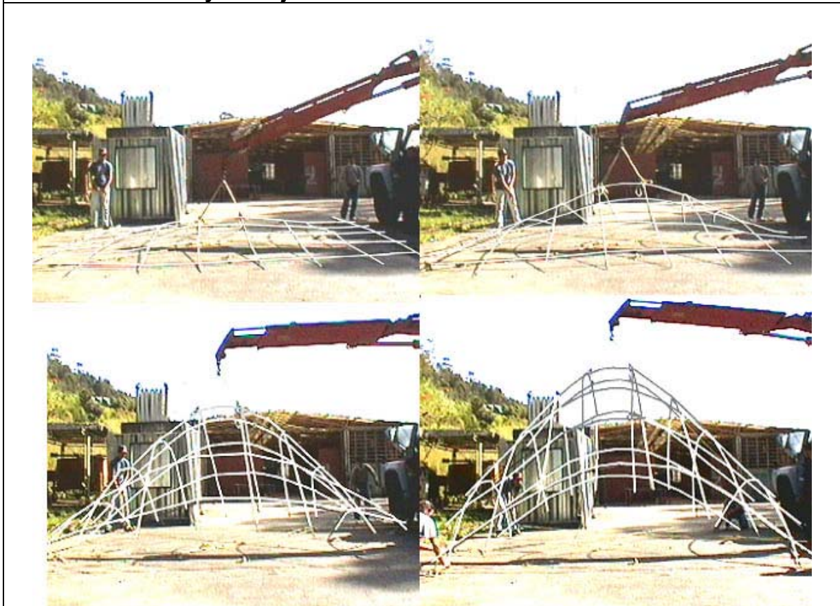
Cuadro N° I-5: Resultado de la obtención de la forma de la cúpula abierta
