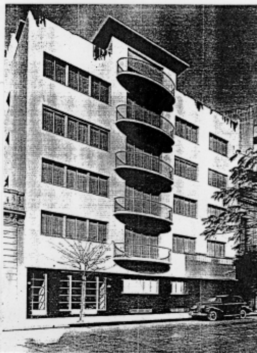
Edificio de renta en Billinghamurst 2527 (Antonio Vilar, 1938).
