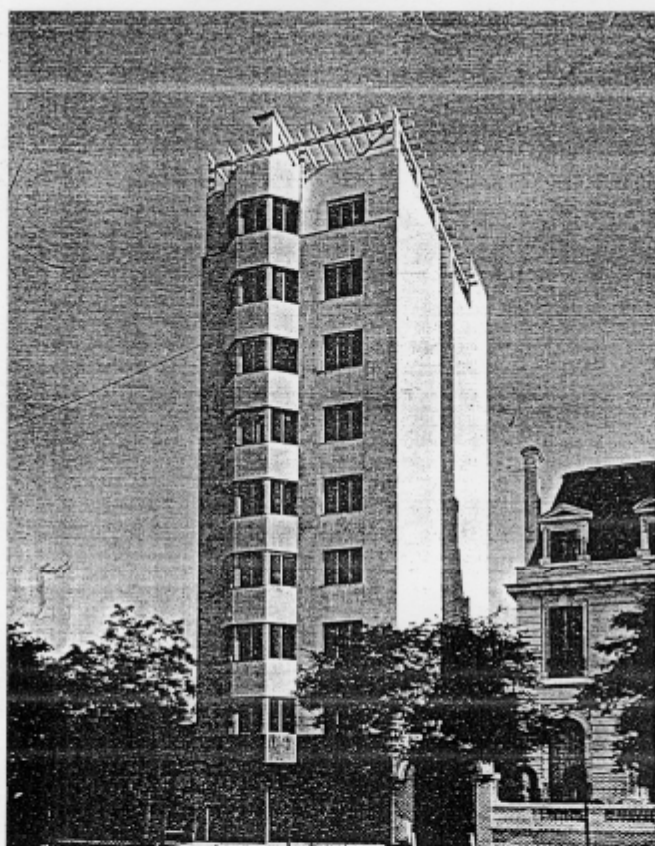
Izquierda sup.: Edificio de renta en C.Entre Ríos 849 y Edificio de renta en Av. Santa Fe 374 (Antonio Vilar, 1932). Izquierda inf. Edificio de renta en Ugarteche 3370 (Antonio Vilar, 1929).
