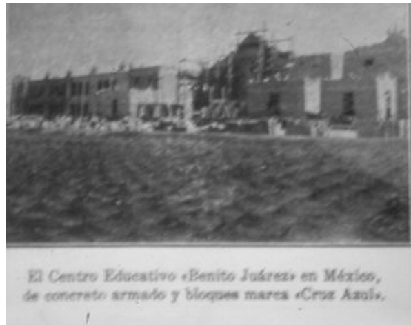
Escuela Benito Juárez en Construcción. 1924. Carlos Obregón. Fuente: Cemento (México, D.F.). Núm. 1, p. 15.
