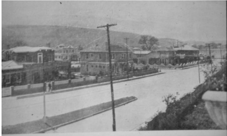
Colonia El Mirador, Monterrey. 1926. Fuente: Cemento (México, D.F.). Núm. 14, p. 8.
