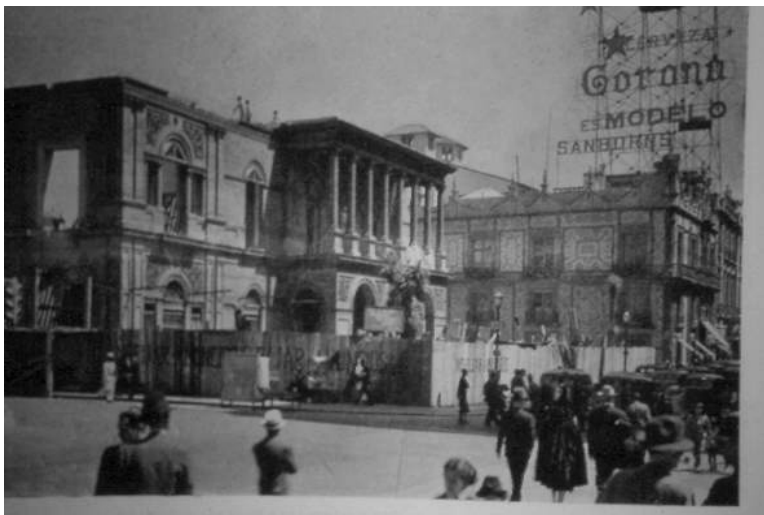
Derribo del Palacio de Guardiola. Rodríguez Arrangoiti. 1871. Fuente: Gómez de Orozco, Federico. La Plaza de Guardiola , El Banco de México, México, 1942, p. 94.
