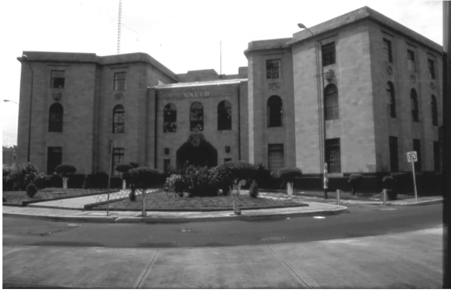
Departamento de Salubridad. Carlos Obregón. 1926-1929. Fuente: Fotografía del autor.
