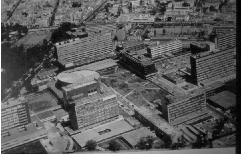
Centro Médico Nacional. Enrique Yáñez. 1954-1958. Fuente: Yáñez, Enrique. Del Funcionalismo al Post-Racionalismo, Ensayo sobre la Arquitectura Contemporánea en México , UAM-Limusa, México, 1990, p. 228.
