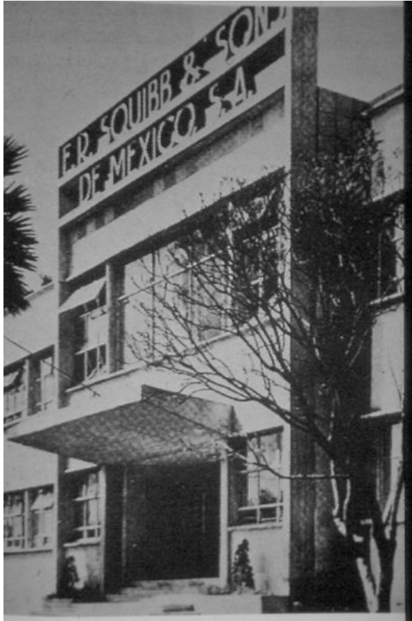
Laboratorios Squibb & Sons de México. Carlos Obregón. 1943. Fuente: Guía de Arquitectura , CACM-SAM-Junta de Andalucía, México, 1999, p. 279.
