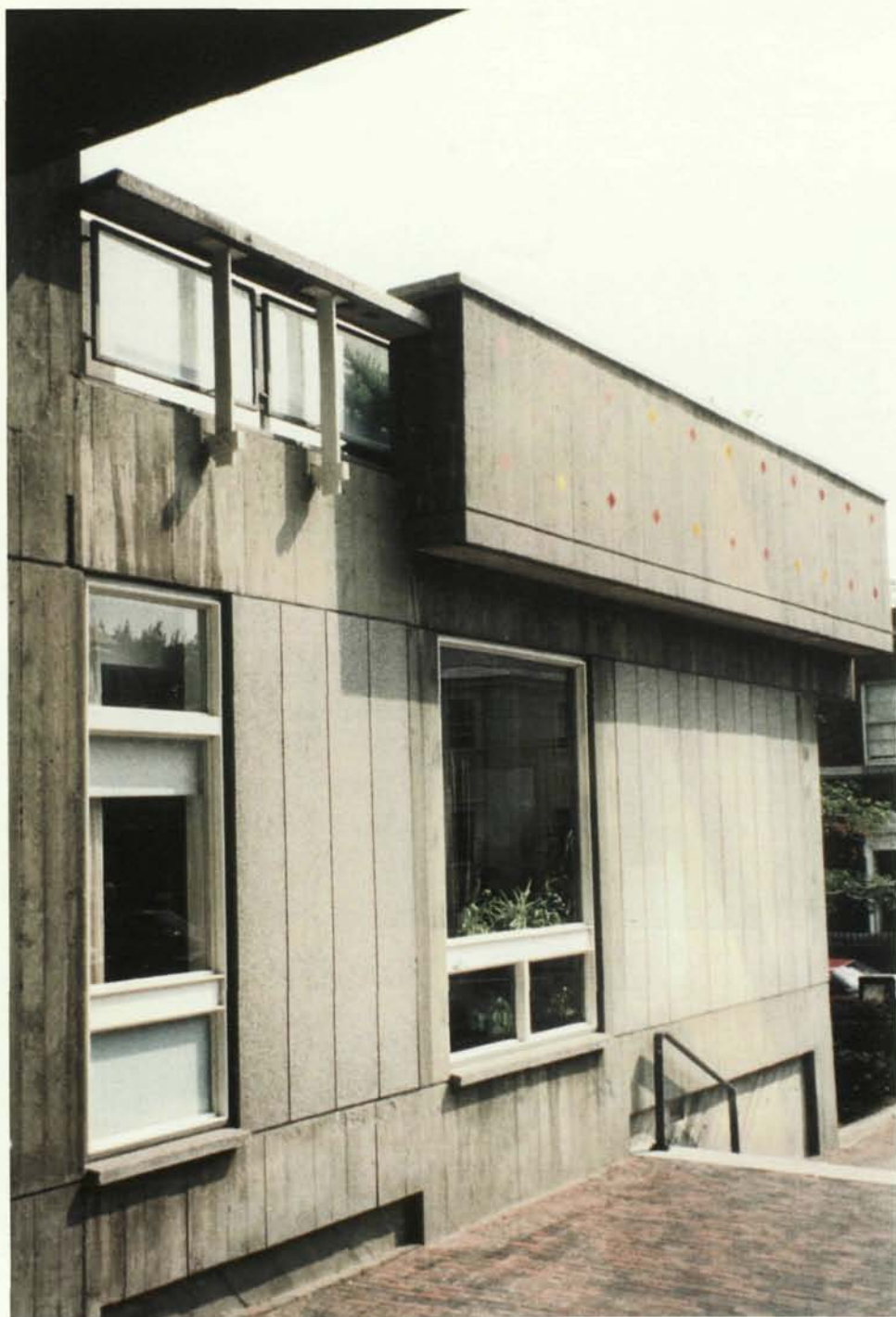
ELS DOS MATERIALS PREFERITS PER SERT: PEDRA ARTIFICIAL I FORMIGO VIST. DETALL DE HOLYOKE CENTER.
