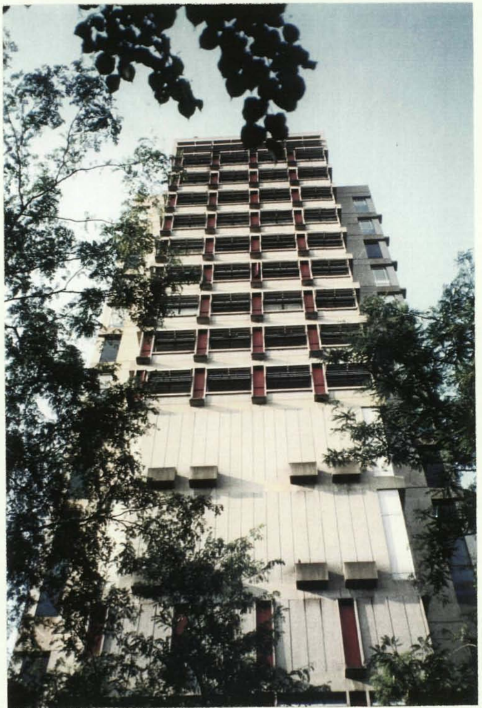
FAÇANA LATERAL DE LA TORRE DE DRET I EDUCACIO DE BOSTON UNIVERSITY: PORTICONS VERMELLS PER A LES FINESTRES DE VENTILAR.
