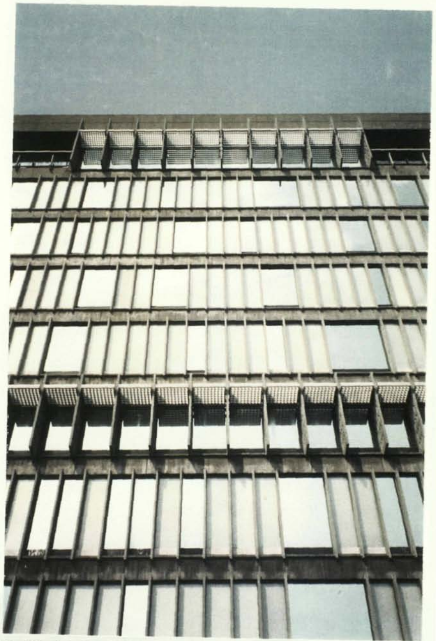
ESTAT ACTUAL DE LA FAÇANA SUD DE HOLYOKE CENTER. ELS VIDRES TRANSPARENTS HAN ESTAT SUBSTITUITS PER VIDRES REFLECTANTS PERDENT EL VALOR DE CONTRAST AMB ELS TRANSLUCIDS.
