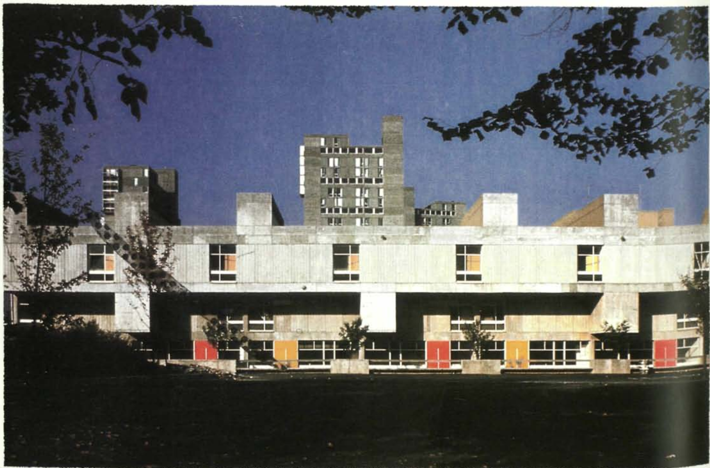
ESCOLA MARTIN L. KING. FAÇANA A LA AVINGUDA PUTNAM, DAVANT DE PEABODY TERRACE
