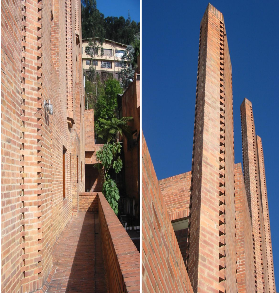
Chimeneas escultóricas del conjunto. Imágenes por autora.
