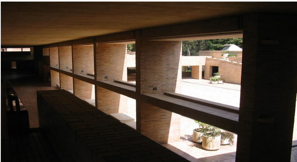
Costados perimetrales del patio central...
