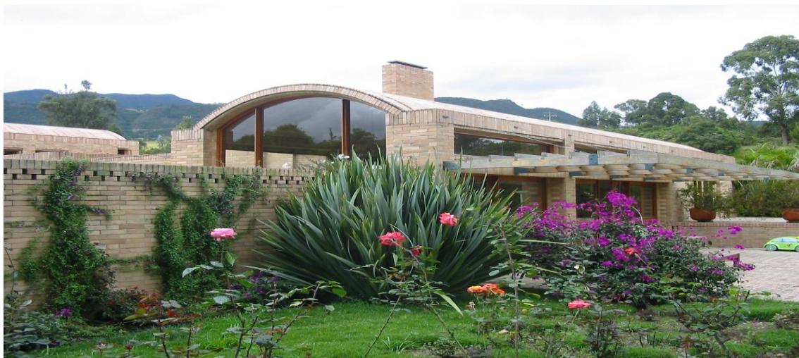
Obras Casa Río Frío y Casa Familiar en Tenjo por Rogelio Salmons. Imágenes por autora.
