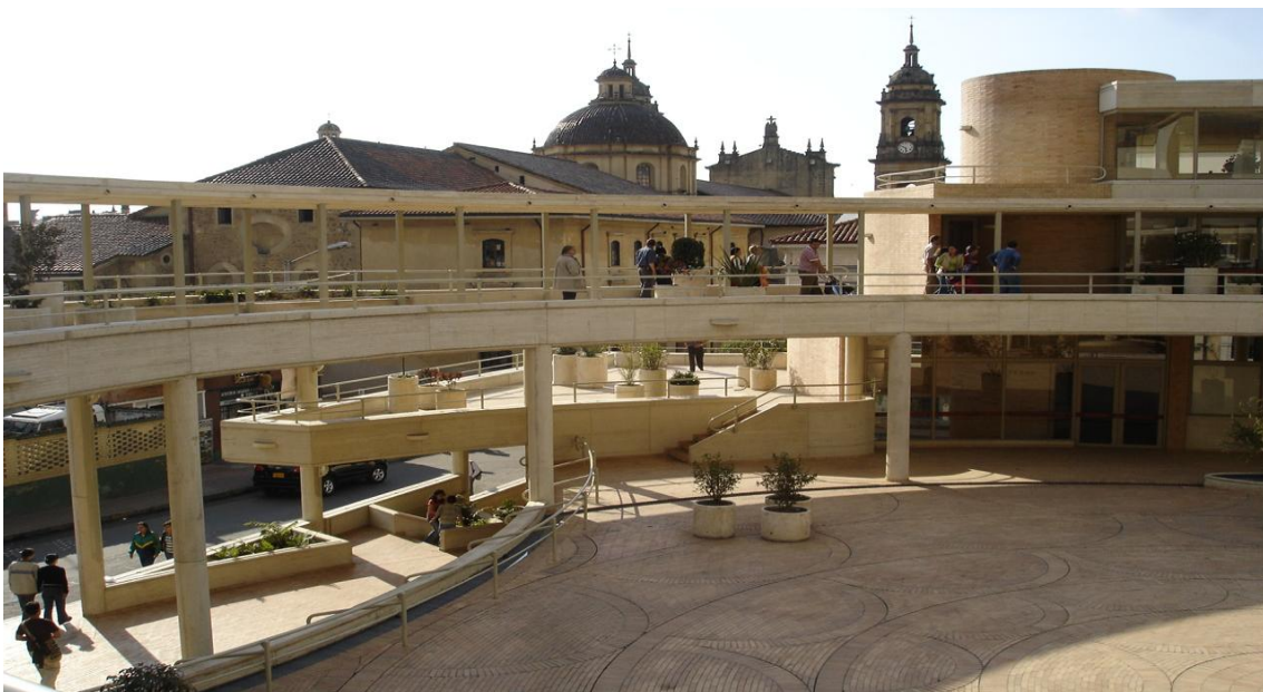
Acceso lateral del Centro Cultural. Obsérvese cómo se incluye la calle y el andén colonial aledaños. Estos permean el espacio central de la obra. Se observan los espacios cubiertos para el recorrido en los tres niveles superiores.
