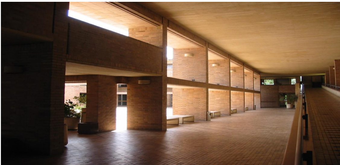
Brise Soleil conformado por columnas y vigas alongadas. Imágenes por la autora.
