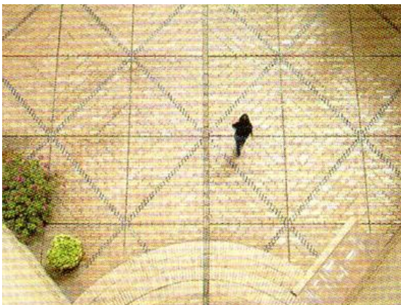
Pavimento en ladrillo con dilataciones
