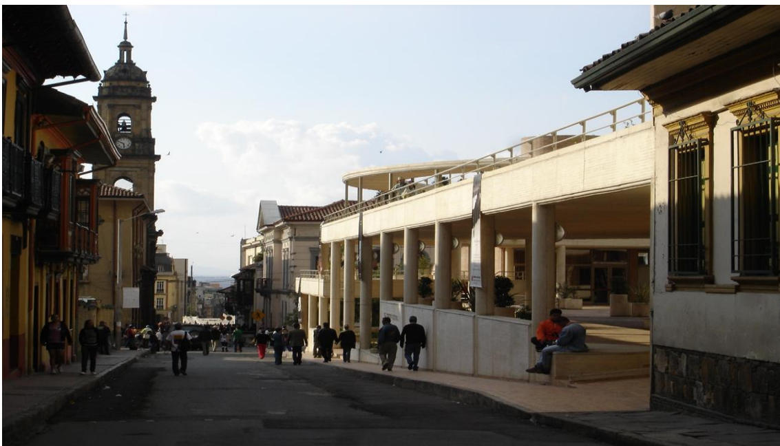
Paramento y anden del Fondo de Cultura. Nótese cómo la escala respeta el hilo conductor de los edificios que le circundan.
