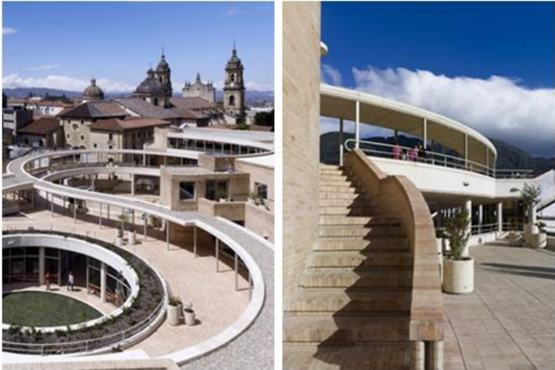
Imágenes de ascenso a cubiertas por Asocreto y Enrique Guzmán.
