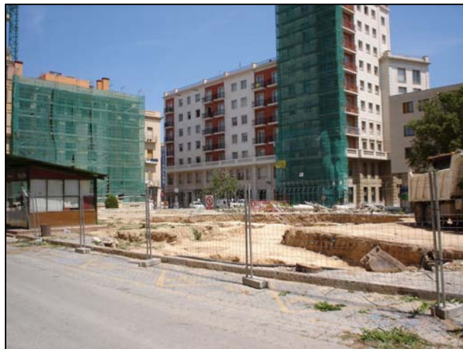
Figura 4.8: La plaça del Pati, el petit CBD de Valls, durant la construcció de l'aparcament subterrani l'any 2005 Font: elaboració pròpia (2005).
