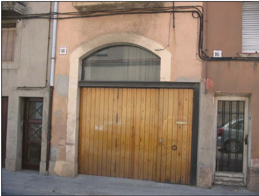
Figura 6.7: Porta entre mitgeres readaptada per a l'aparcament, a Vilafranca del Penedès. Font: pròpia (2008).
