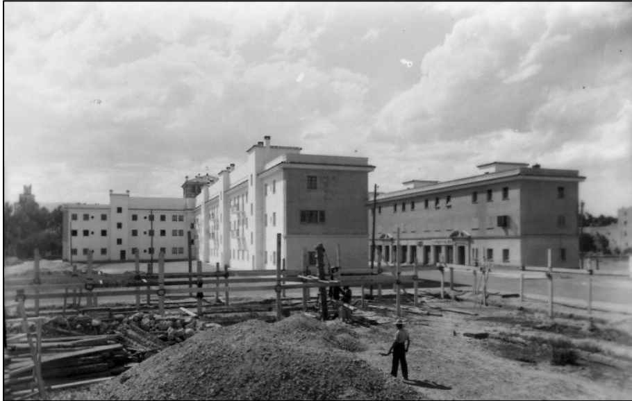
Figura 5.2: Construcció de las cases barates de Ferreries a partir del 1943. Font: Arxiu Històric Comarcal de les Terres de l'Ebre.
