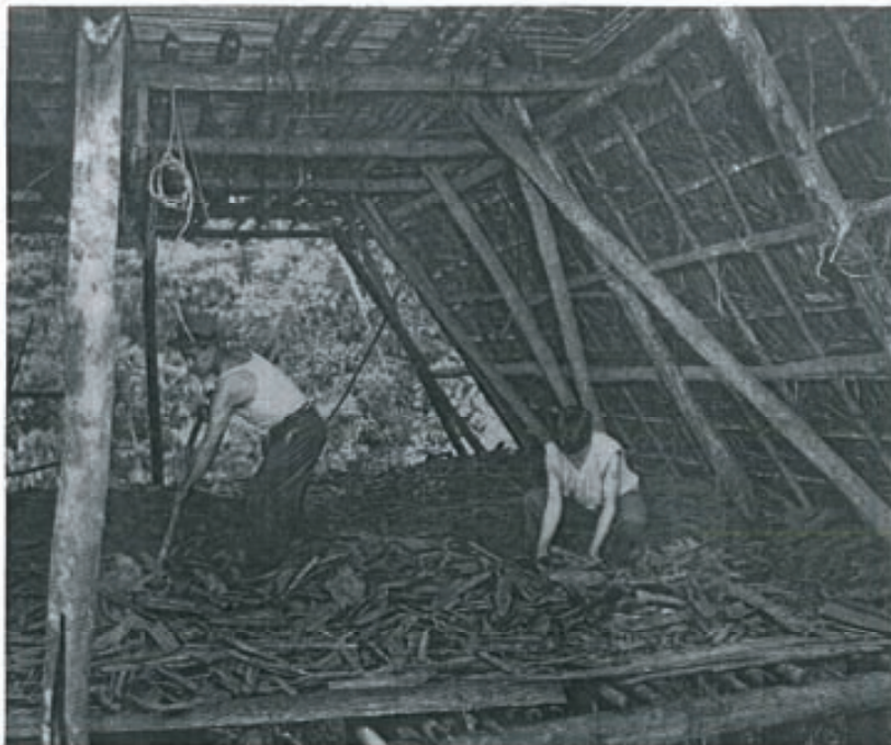
Foto 4.5 Parte superior del secadero (abajo había fuego a leña)
