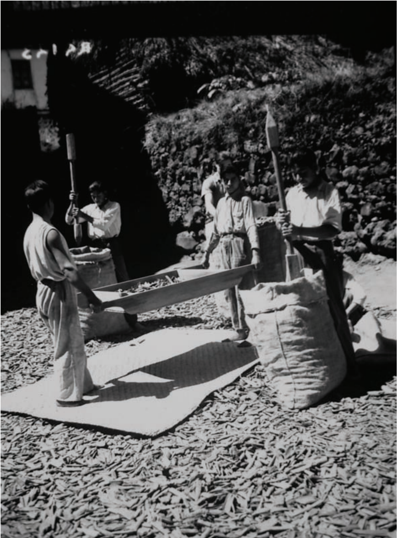
Secadero en Baños
