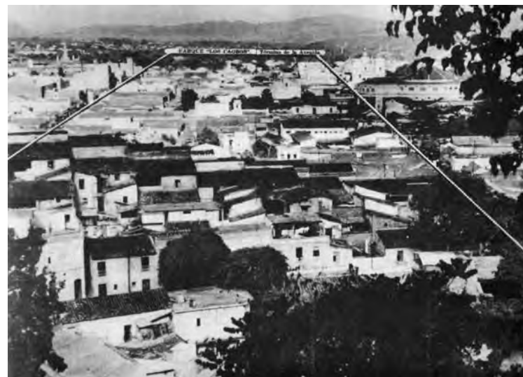
66. Edificios y casas que fueron demolidas para dar paso a la avenida Bolívar.
