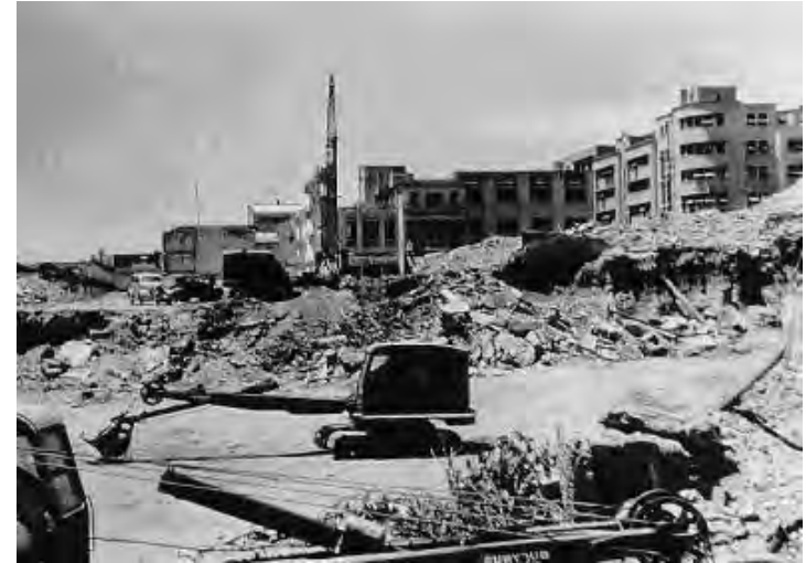
50. Edificios demolidos para dar paso a la construcción de la avenida Bolívar, Caracas hacia 1950.
