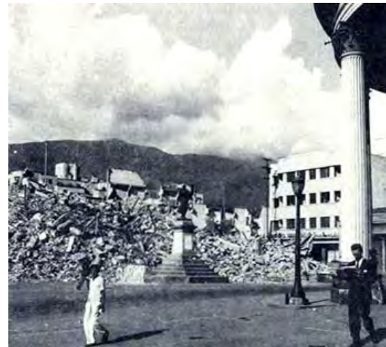
49. Demolición del hotel Majestic, 1949. Desde sus ruinas comenzó la nueva Caracas.
