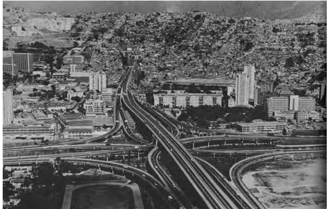
70. Distribuidor La Araña, construido en la década del 50. Caracas
