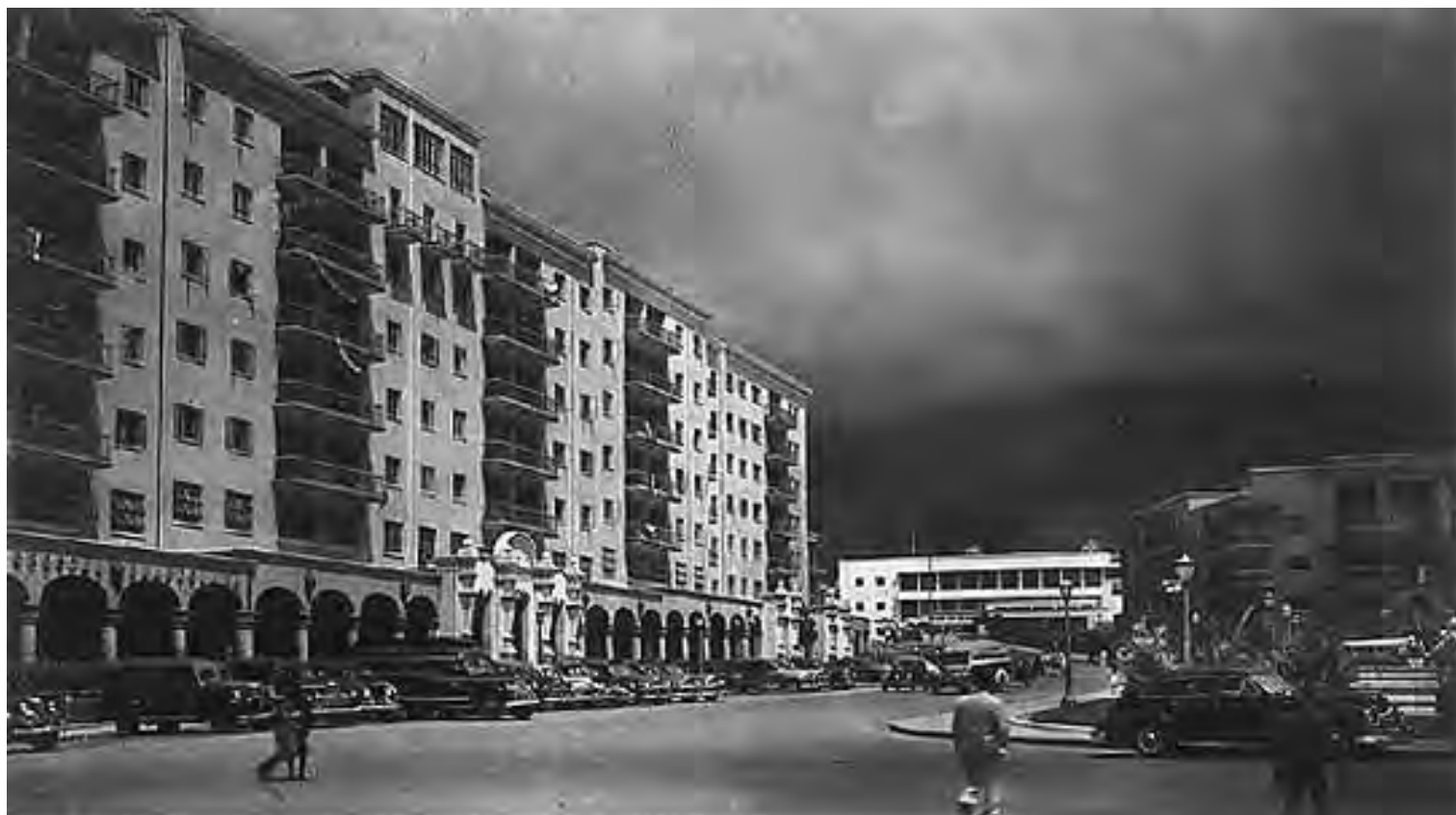
47. Vista de uno de los edificios desde la plaza de la reurbanización de El Silencio, 1950.
