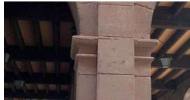
Capitel y columna de la planta baja
