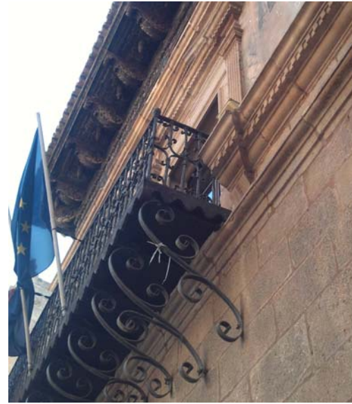
Detalle de la barandilla
