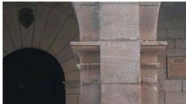
Capitel y columna de la planta baja
