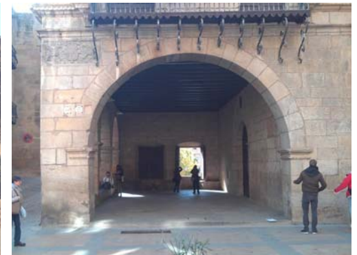
Detalle de los arcos de planta baja
