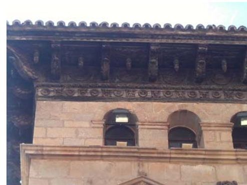
Detalle del coronamiento de la fachada
