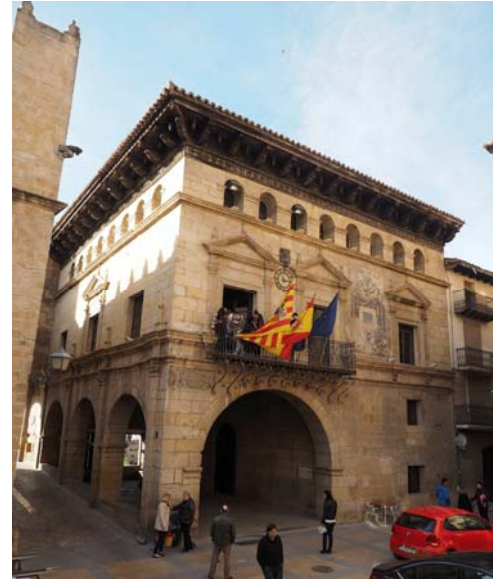
Vista exterior del Ayuntamiento de Valderrobres
