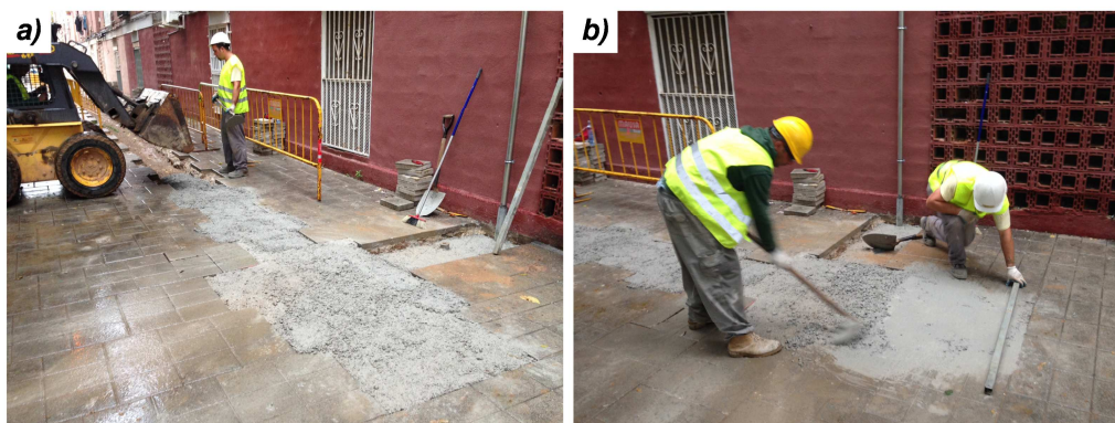
Figura A2. 114 – a) proceso de vertido del hormigón expansivo; b) enrasado y acabado superficial del hormigón visto
