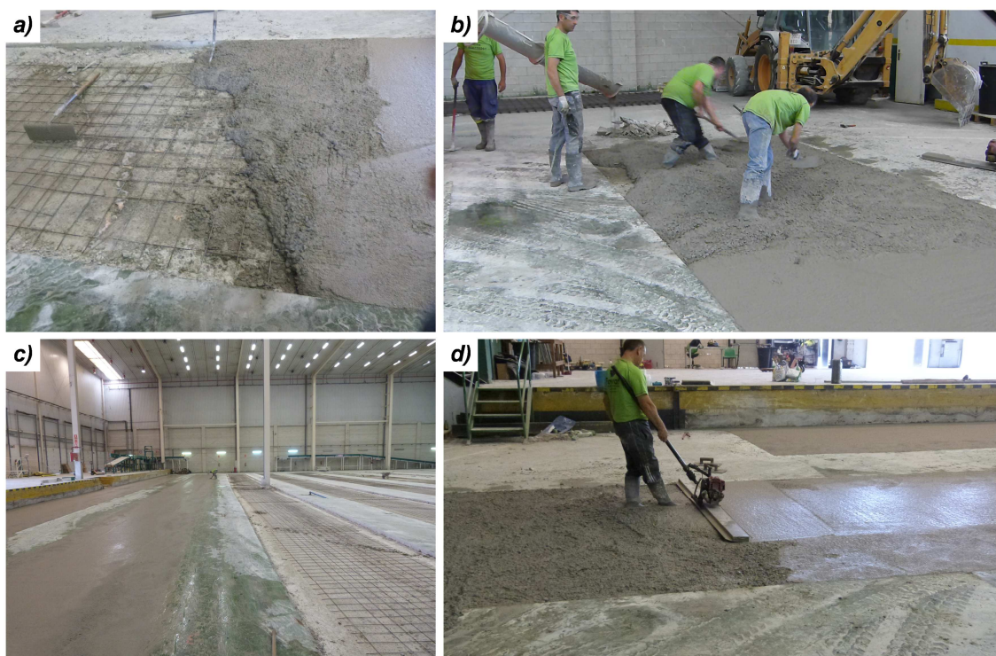
Figura A2. 91 – Puesta en obra y proceso de hormigonado
