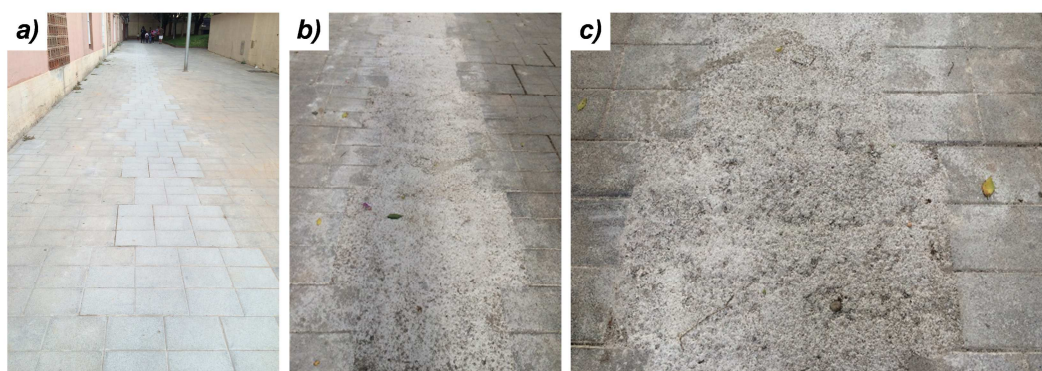
Figura A2. 115 – a) estado del pavimento a los 14 días de edad; b) acabado de los 10 últimos metros de la zanja; c) detalle de acabado producido por la lluvia
