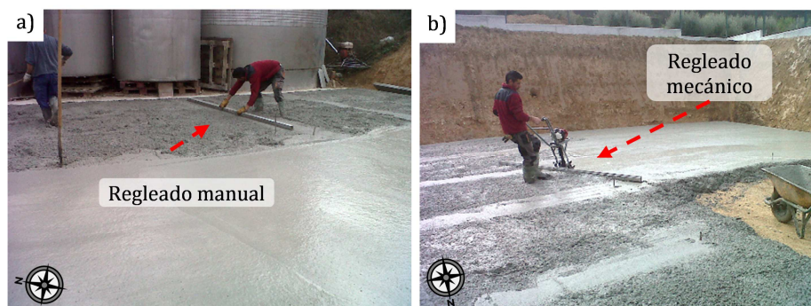
Figura A2. 3 – a) regleado manual del hormigón; b) acabado final mediante regla vibradora
