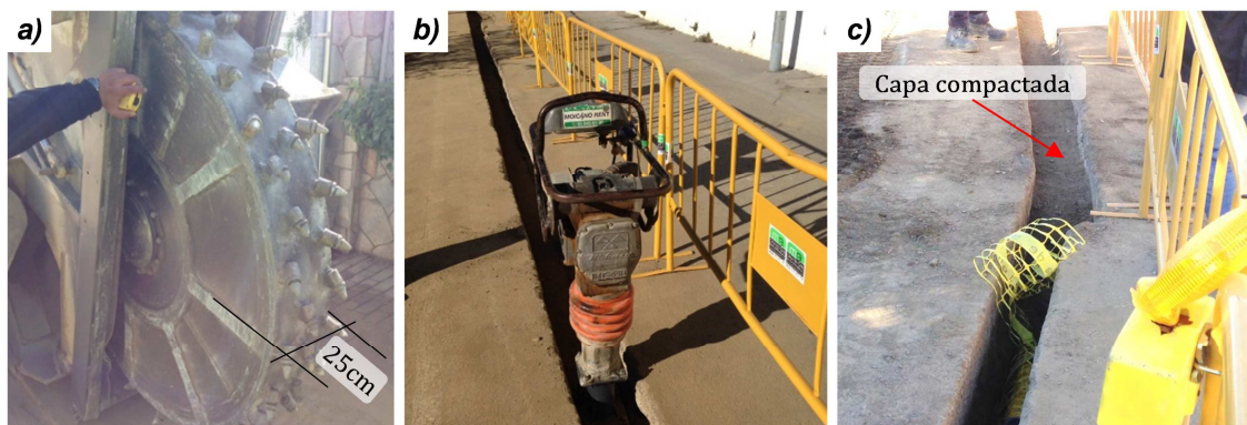
Figura A2. 117 – a) rozadora de 25cm; b) compactadora adaptada a las dimensiones de la zanja; c) detalle de sección con capa de material granular compactada
