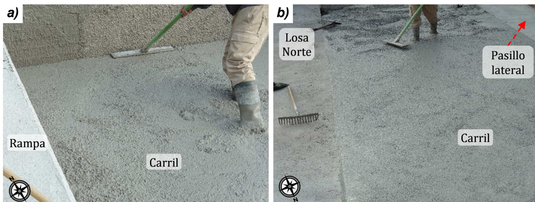
Figura A2. 85 – Acabado del carril manualmente
