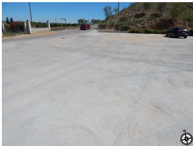
Figura A2.109 - Vista general de la losa con adición de cal a los 3 meses de edad
