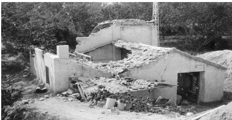
Efecto de la explosión en una casa de huerta cercana al polvorín
