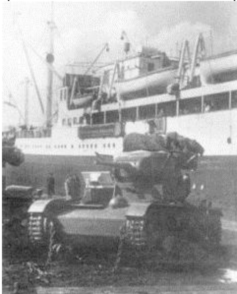
Descarga de tanques en puerto de Cartagena
