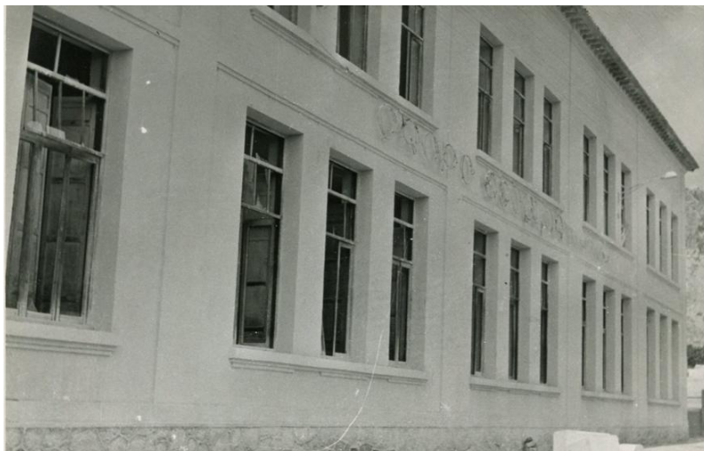
Daños producidos por la explosión del polvorín en el colegio Miguel Medina
