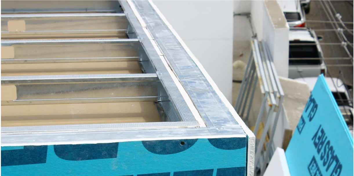
Figura 19 Fabricación de la cubierta de la habitación del Modelo Experimental. Fuente: Propia del autor.
