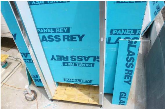
Figura 9 Colocación de paneles aislantes de EPS en el interior de la Torre (T) de la chimenea solar. Fuente: Propia del autor.
