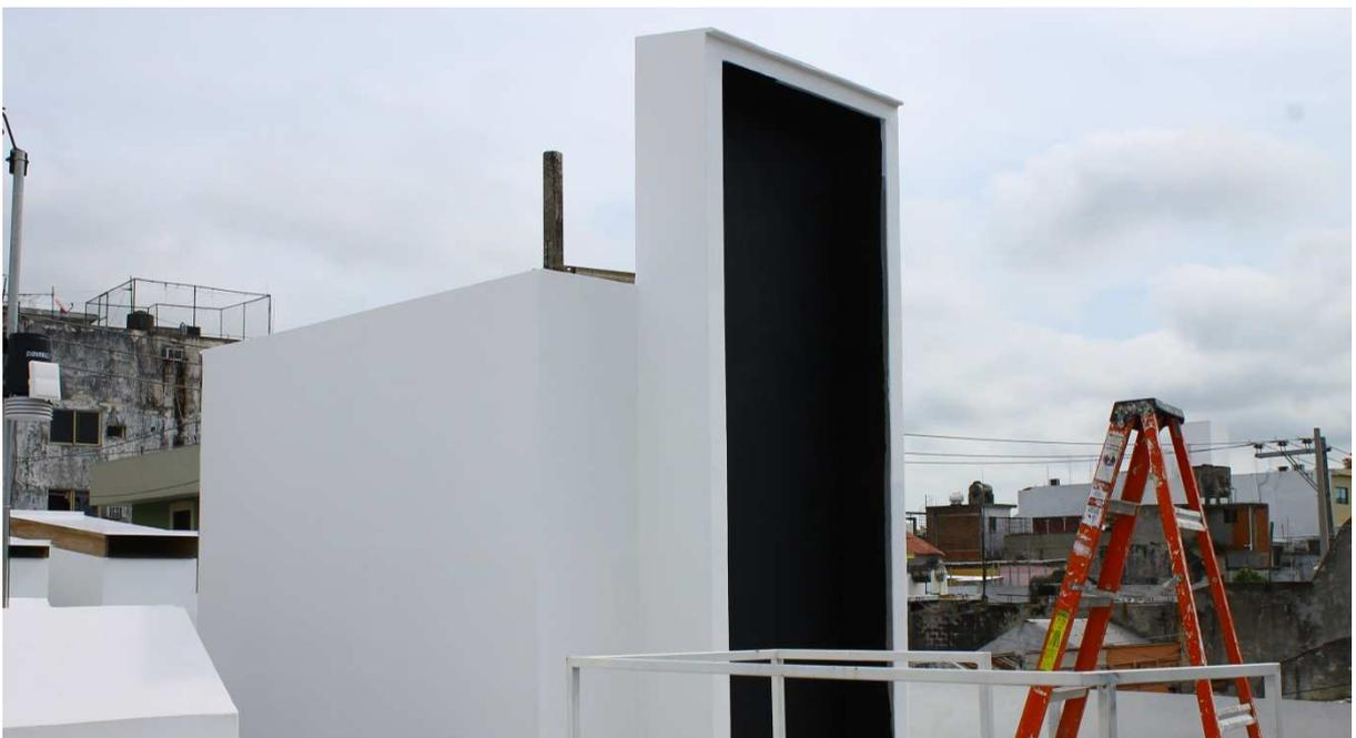
Figura 24 Aplicación de acabados de color selectivo en el interior de la chimenea solar (CHS). Fuente: Propia del autor.
