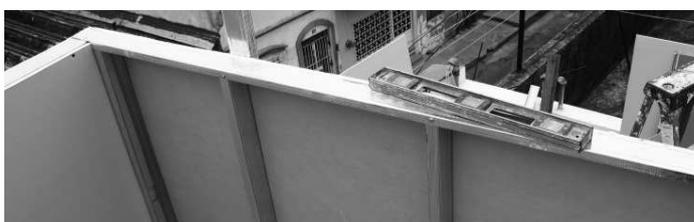
Figura 16 Instalación de los paneles exteriores de GlassRey en el Modelo Experimental. Fuente: Propia del autor.
