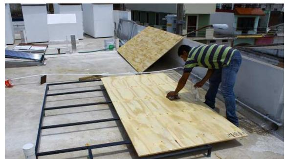
Figura 5 Colocación de madera contrachapada de pino como suelo de Modelo Experimental. Fuente: Propia del autor.
