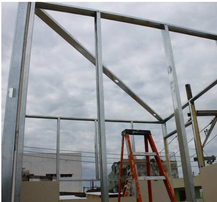
Figura 14 Detalle de los perfiles galvanizados de la habitación del Modelo Experimental. Fuente: Propia del autor.
