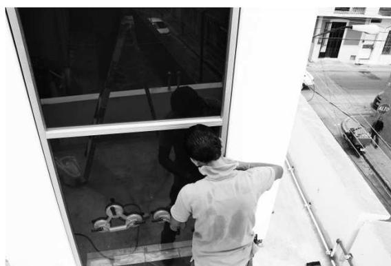
Figura 11 Instalación de vidrio transparente en fachada sur de la chimenea solar. Fuente: Propia del autor.
