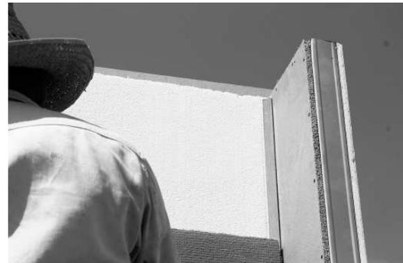
Figura 8 Detalle de colocación de paneles de cemento Permbase en el interior de la Torre (T) de la chimenea solar.
