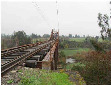
Figura 7. La presencia de antiguos puentes y vías ferreas era otra pista sobre la historia de este territorio. Fuente: autor
