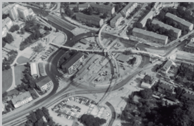
587. Construcción de la pasarela sobre Bucheggplatz, Zürich, 1972. Fotografía Werner Friedli, 1972, E-Pics, ETH
