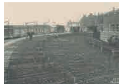
576. En diciembre de 1933 se construye la estación de metro y se inicia la construcción del lado este del Slussen. El puente provisional se derriba y un andamiaje en el bucle oeste marca el lugar donde en 1953 Arthur von Schmalensee construirá el edificio elíptico de Kolingsborg. En la fotografía superior se enseña el momento de la armadura del bucle norte, sobre el Blå Bodarna.
