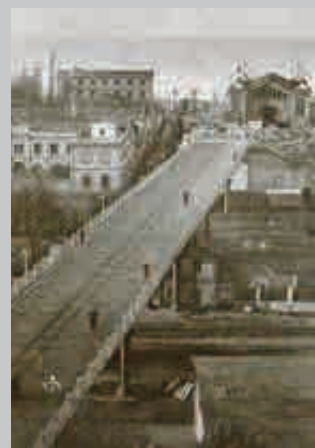
54. La Exposición de 1888 en la Ciutadella se extendía hasta la sección marítima mediante un puente provisional que salvaba la playa de vías. Una imagen elocuente de enlace .
