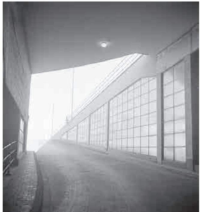
402. Vista de la rampa este que se adentra en la cota -1 del Slussen. Se observa aquí el despiece de la carpintería y las superficies lisas de asfalto y hormigón.
