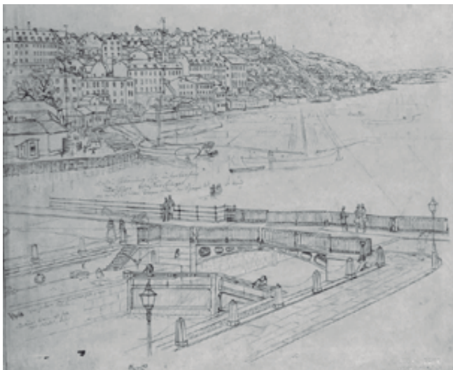
117. La construcción de la infraestructura hidráulica venía acompañada de una elaborada urbanización: puentes, barandillas, iluminación, báculos, escaleras, aceras, bordillos de piedra... hecho que demuestra el papel urbano creciente de este enclave de la ciudad. Dibujo de Carl Georg Enslén, 1856.
