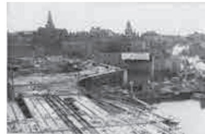
575. Noviembre de 1933. La definición del límite oeste se perfila con claridad, con la solución de escaleras y rampas perimetrales. El ascensor Katarina se desmonta para proceder a la construcción del nuevo edificio de oficinas proyectado por KFAI como prolongación y reforma del edificio existente.
