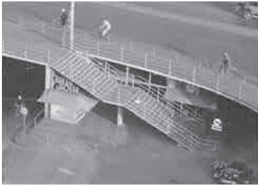
400. Diseño de 1935 de la escalera de acceso del bucle este sobre un único pilar central. La escalera se ubica perpendicular al paso inferior, extendiendo la barandilla para acompañar al peatón hacia Södermalmstorg. Tras ella y bajo ella se pueden observar las cristaleras de los comercios que se asoman bajo la infraestructura viaria. Resalta también el exquisito diseño de la señalética.
