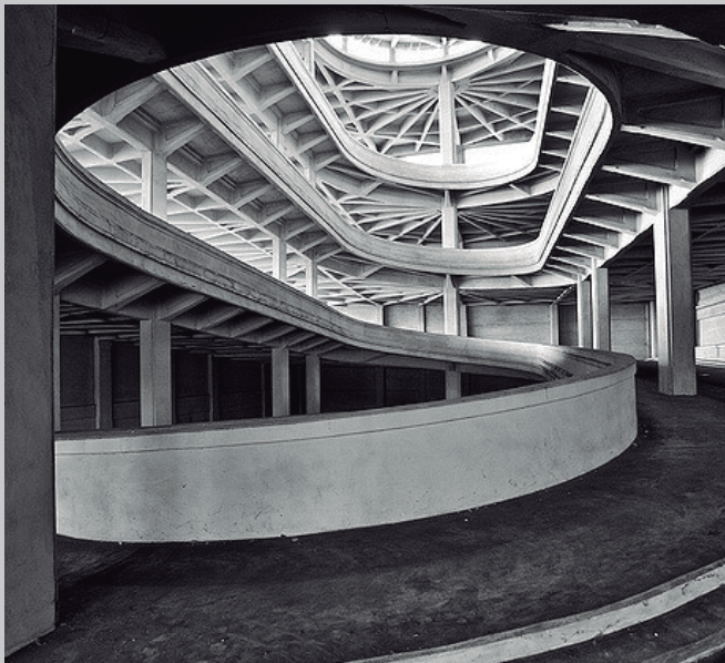
431. Vista de la rampa sur, la segunda en realizarse. Se observa su compleja geometría triangular.
