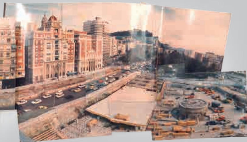
585. Construcción de Plaza de la Marina, Málaga, M. de Solà-Morales, 1987. Fotografía Fons Manuel de Solà-Morales, COAC
