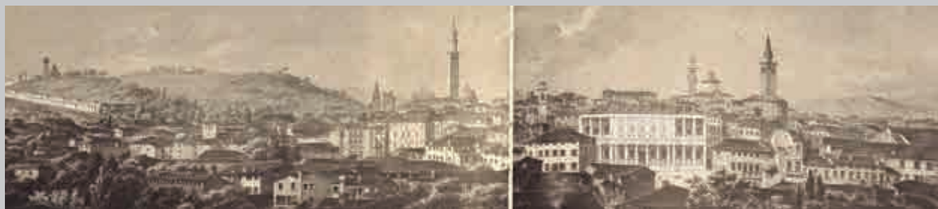
213. Los portici de Francesco Muttoni conectan la ciudad de Vicenza con lo alto del Monte Berico. En estas dos ilustraciones se observa por un lado la lógica de iteración de los pórticos pero también su posición respecto a la ciudad y la relación con las obras de A. Palladio (naranja). Manipulación de grabado en AA.VV., Vicenza città bellissima. Iconografia vicentina a stampa dal XV al XIX secolo , Padus Cremona, Vicenza, 1983, pp.247-248 (inferior) Manipulación de originales en Ibid. , pp. 86 y 272
